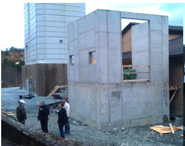
Bilde 33 – Espeland, nybygg under oppføring 1/2
