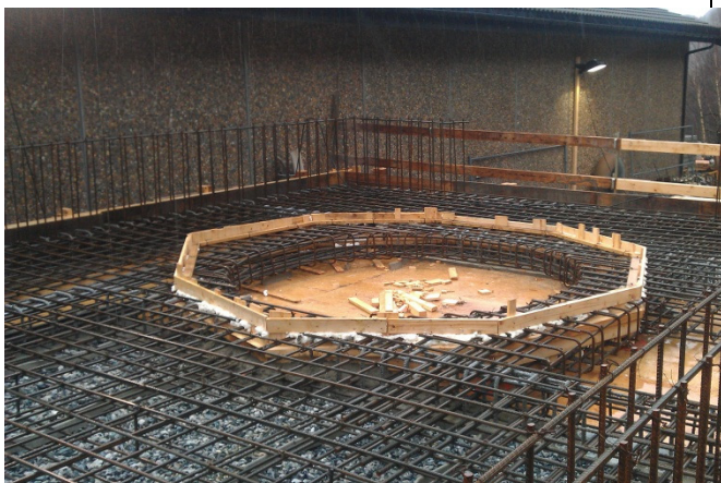
Bilde 31 – Espeland, hull til utløpskum under turbin
