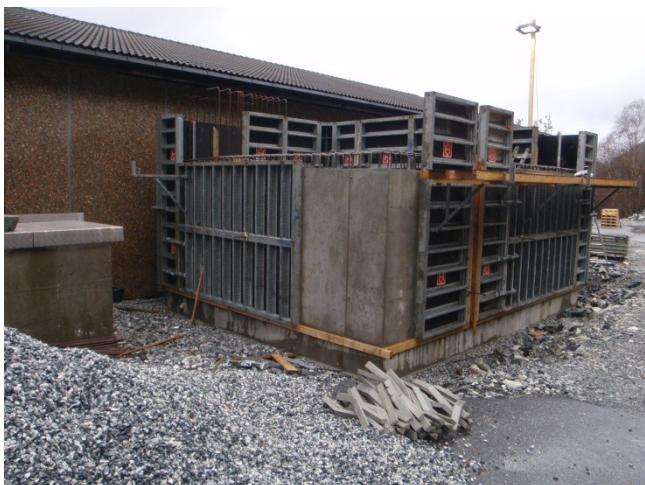
Bilde 29 – Espeland nybygg, forskalingsarbeider
