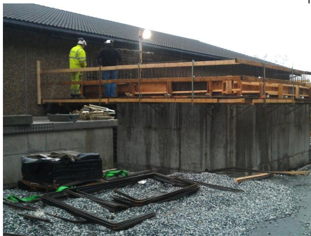
Bilde 30 – Espeland nybygg under oppføring
