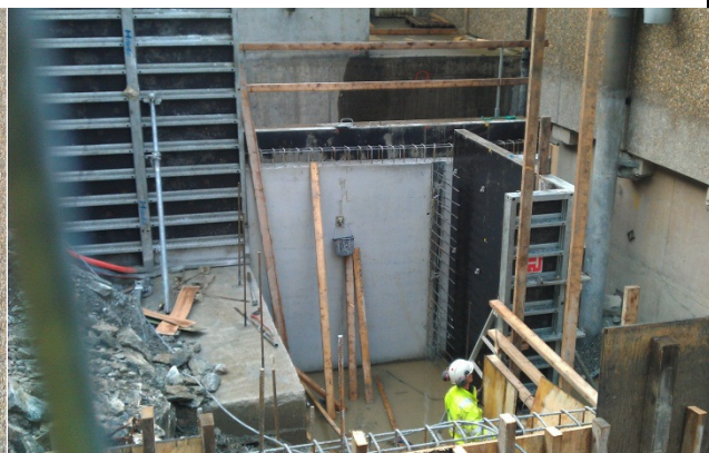
Bilde 24 – Espeland - grunnarbeider
