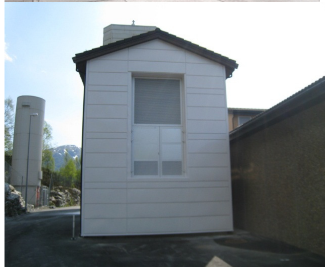
Bilde 46 – Espeland innløps- og avløpsrør (øverst), og fasade mot nord (nederst)
