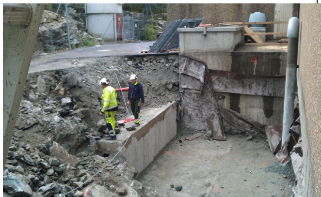
Bilde 23 – Espeland – gravearbeid påbegynt
