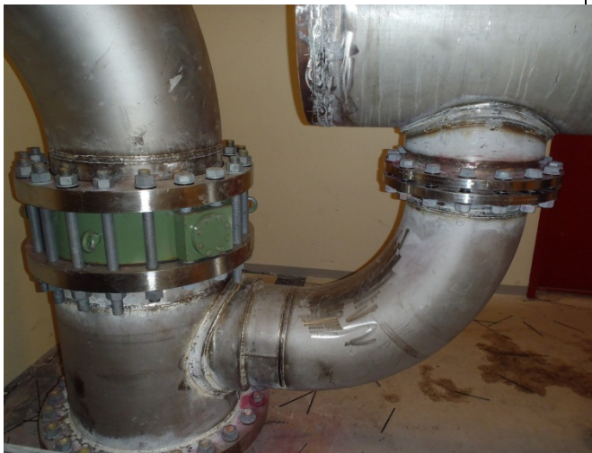
Bilde 39 –Espeland, omlegging av opprinnelig innløp
