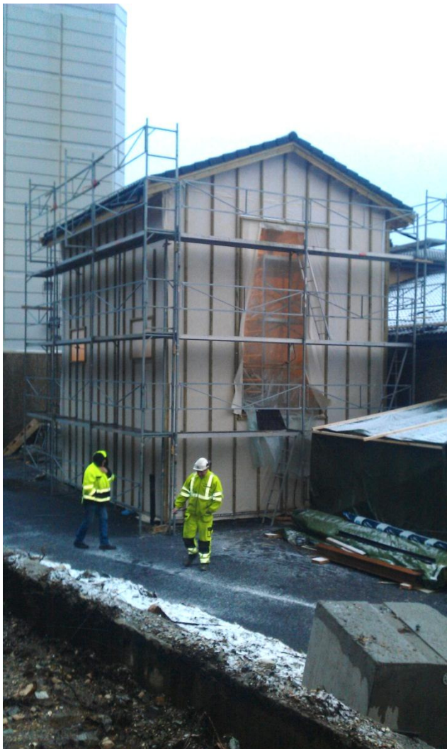
Bilde 37 –Espeland fasadearbeid
