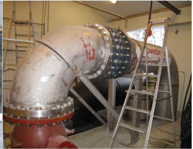
Bilde 36 – Espeland hovedinnløp , før omlegging
