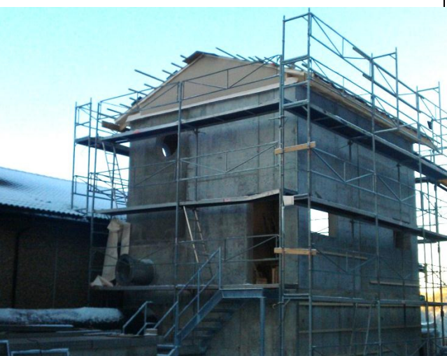
Bilde 34 – Espeland, nybygg under oppføring 2/2
