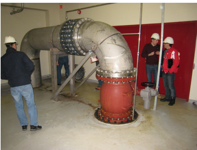
Bilde 21 – Espeland hovedinntaksrør, før byggestart
