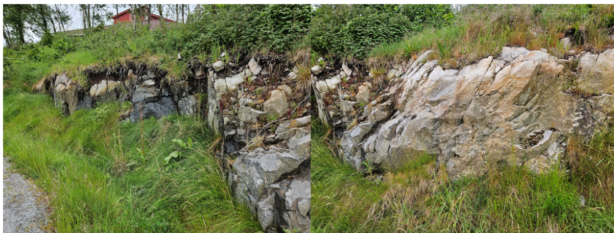
Figur 8: Bilder av bergmassen ved tomten viser noe jordfylte sprekker opp mot overflaten, men at de er mer sammenvokste mot dybden.
