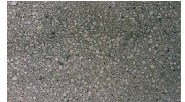
Gulv: Vannbåren gulvvarme. Slipt, vokset betong.
