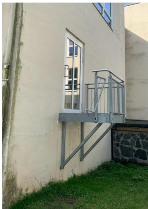
Figur 4 Eksisterende dør med repos Østbygget
