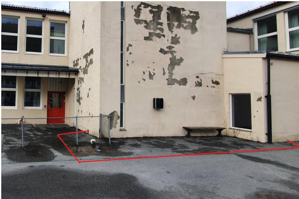
Figur 6 Masseutskifting ved hovedinngangsparti
