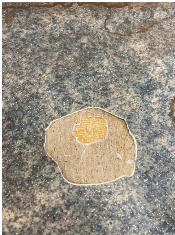
Figur 8: Lysebrunt vinylbelegg (E1.1a) og blått vinylbelegg (E1.1b) ble prøvetatt i rom E1.1 i etasje 1. Det ble ikke påvist asbest i prøvene.
