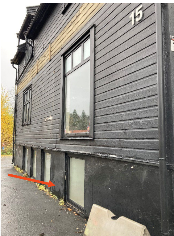
Figur 34: Betongprøve (U2) av kjellervegg ble prøvetatt utendørs.
