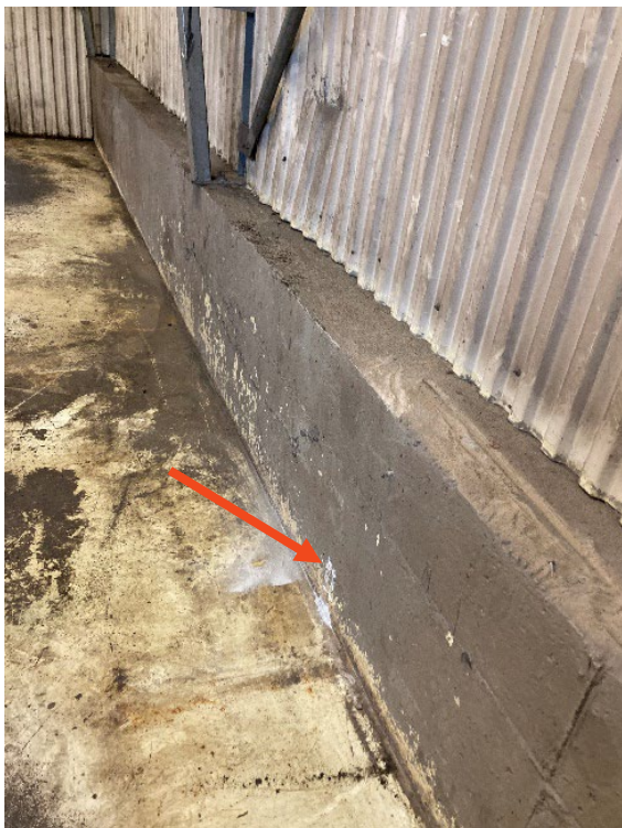
Figur 32: Betongprøve (V3) av vegg ble prøvetatt inne i verkstedhallen.
