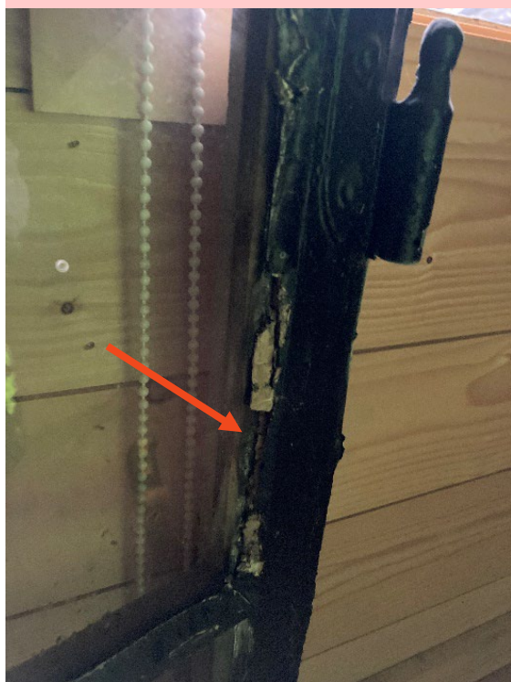
Figur 19: Kitt (E3.1) rundt vindu ble prøvetatt i rom E3.1 i 3. etasje (loftet). Det ble ikke påvist asbest i prøven.
