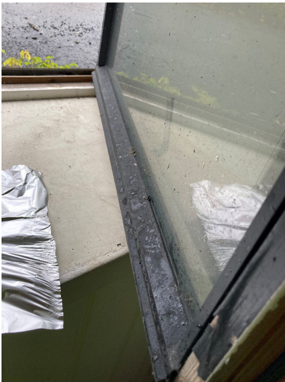
Figur 1: Svart fuge (K1a) ble prøvetatt i vindu (fasadesiden) i rom K1 i kjeller. Det ble ikke påvist asbest i prøven.
