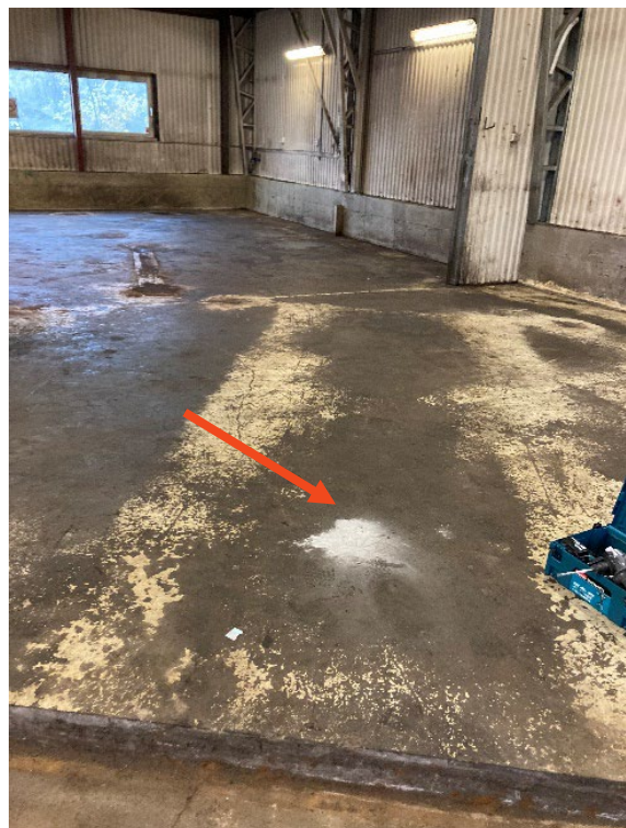
Figur 31: Betongprøve (V2) av gulv ble prøvetatt inne i verkstedhallen.
