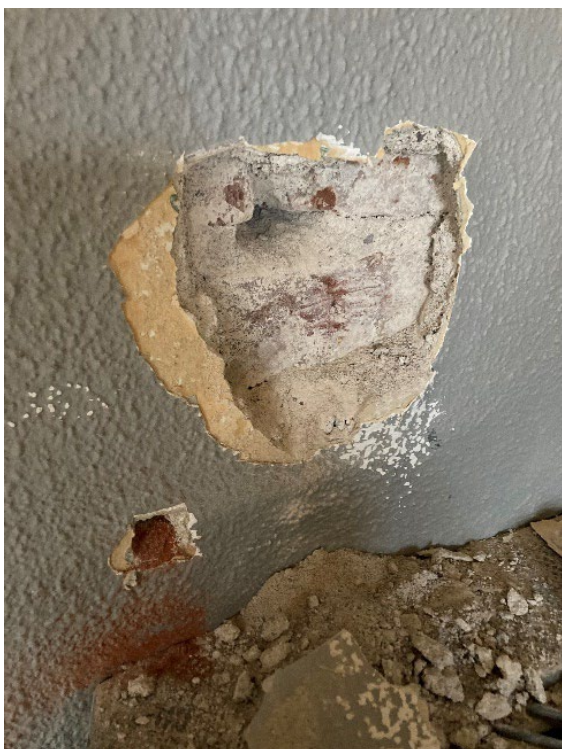
Figur 14: Murpuss (E2.3b) og mørtel (E2.3c) ble prøvetatt i rom E2.3 i 2. etasje. Det ble ikke påvist asbest i prøven.
