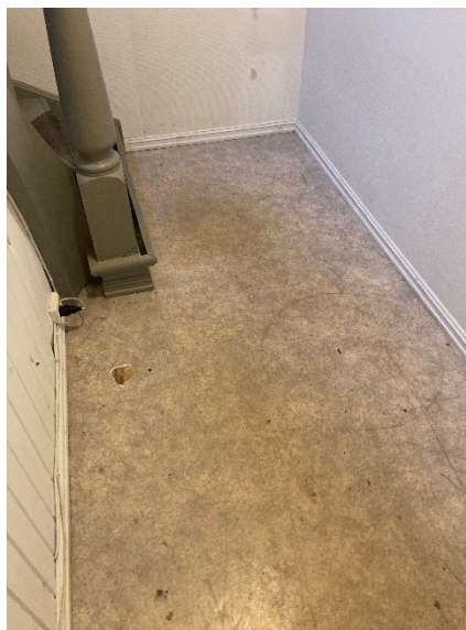
Figur 13: Spraglete grått vinylbelegg (E1.10) ble prøvetatt i rom E1.10 i etasje 1. Det ble ikke påvist asbest i prøven.
