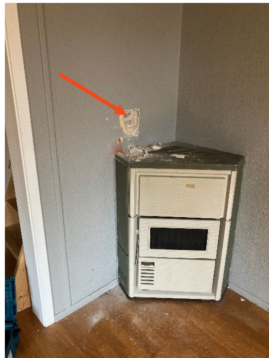
Figur 33: Maling (E2.3a) og murpuss (E2.3b) ble prøvetatt av vegg bak parafinovn i rom E2.3 i 2. etasje.
