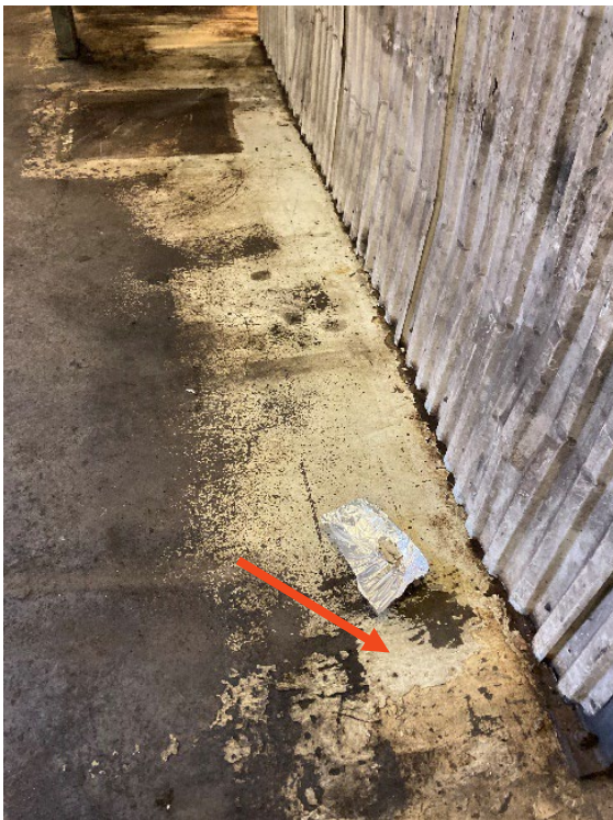
Figur 30: Hvit maling (V1) på gulv ble prøvetatt inne i verkstedhallen.
