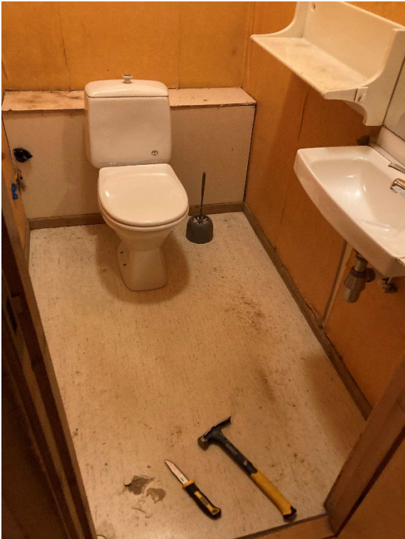
Figur 11: Hvit/beige vinylbelegg (E1.7a), prikkete brunt vinylbelegg (E1.7b) og gult lim (E1.7c) over prikkete brunt vinylbelegg ble prøvetatt i rom E1.7 i etasje 1. Det ble ikke påvist asbest i prøvene.
