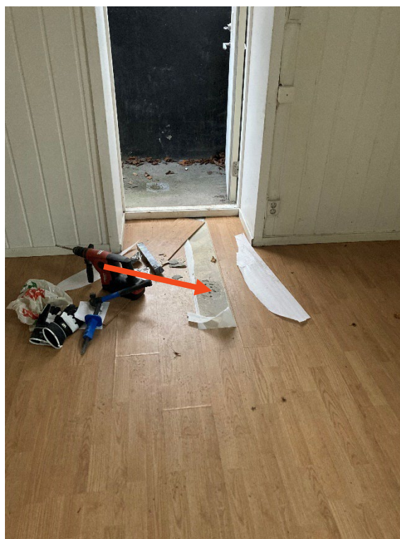
Figur 35: Betongprøve (K2e) av gulv i kjeller ble prøvetatt i rom K1.
