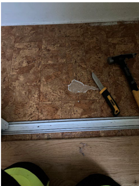
Figur 16: Brunt spraglete vinylbelegg (E2.6) ble prøvetatt i rom E2.6 i etasje 2. Det ble ikke påvist asbest i prøven.
