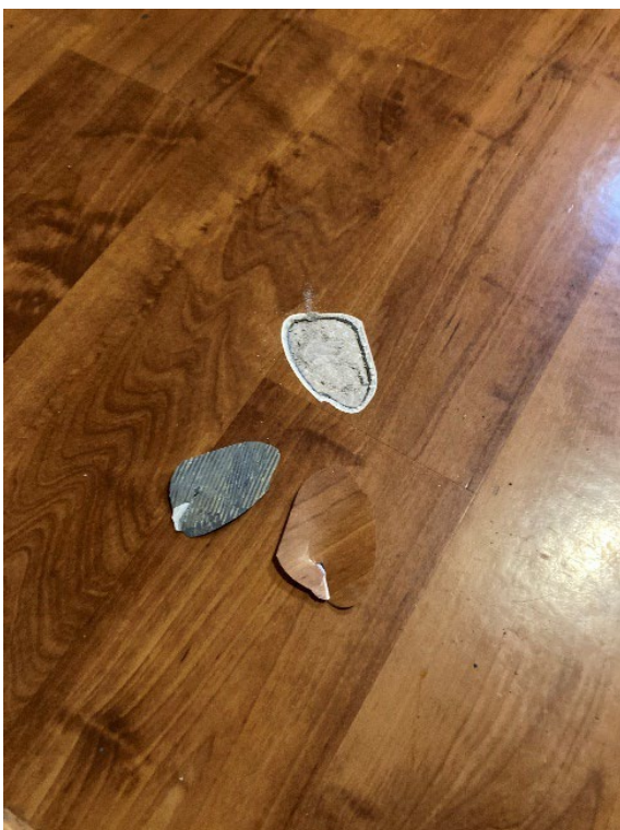
Figur 5: Brunt vinylbelegg (K5a) og svart vinylbelegg (K5b) ble prøvetatt i rom K5 i kjeller. Det ble ikke påvist asbest i prøvene.
