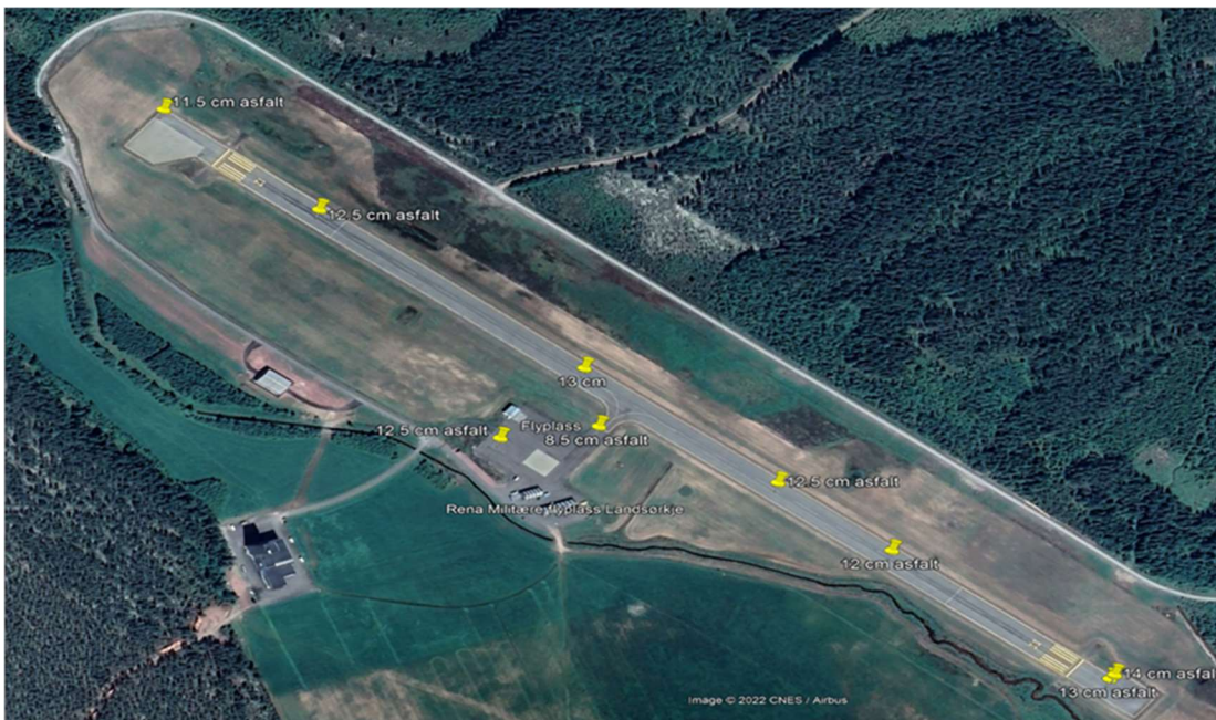
Bilde 4 Viser uttatte borkjerner asfalt (ref. Sweco- Vedlegg 2)
