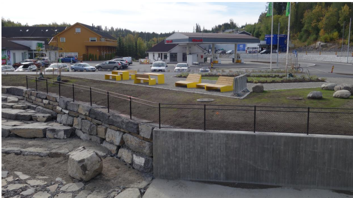
Figur 3-10: Lakkert gjerde montert på natursteinsmur og betong. Lignende rekkverk foreslås montert på tørrmuren ved vannverket.
