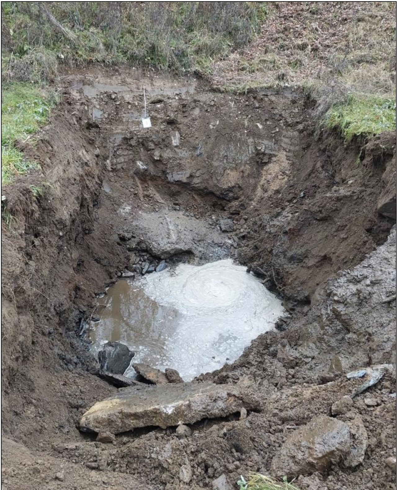
Bilde 4 Prøvegrop vest for eksisterende bygg mot jernbanen. Mye søppel og grov stein Det lukter råttent av gropa. Vannet stabiliserte seg på kote 182,10
