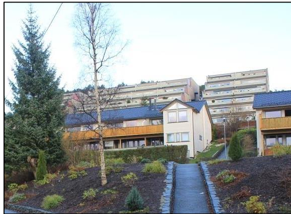
Terrassehus og rekker i øst
