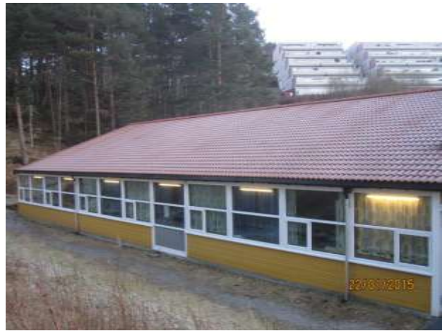
Bilde 38: Fasader med trekledning / brystning.
