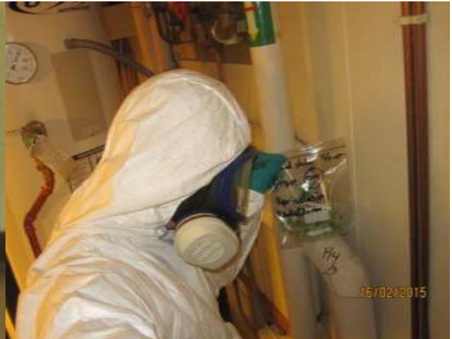
Bilde 19: Prøve 14 rørisolasjon. Ikke påvist asbest
