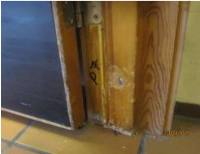
Bilde 17: Prøve 07 Brannør. Ikke påvist asbest
