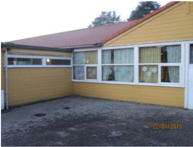
Bilde 37: Fasader med malt trekledning.
