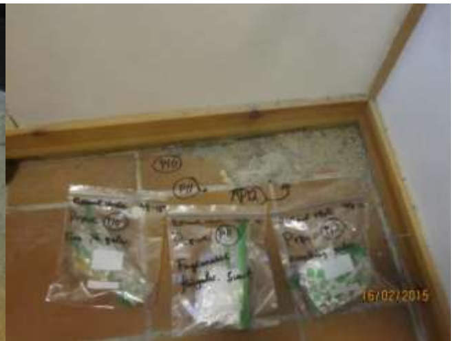
Bilde 16: Prøve P11 fuge og P12 under flis. Ikke påvist asbest
