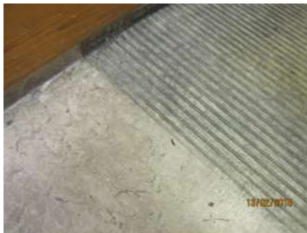
Bilde 27: Gulvbelegg av vinylbelegg i korridor 100. Sorteres og leveres som farlig avfall.
