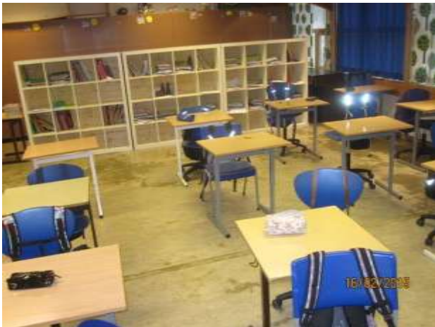
Bilde 22: Typisk klasserom med linoleum belegg. Prøve 05 inneholder Bly. Forurenset avfall
