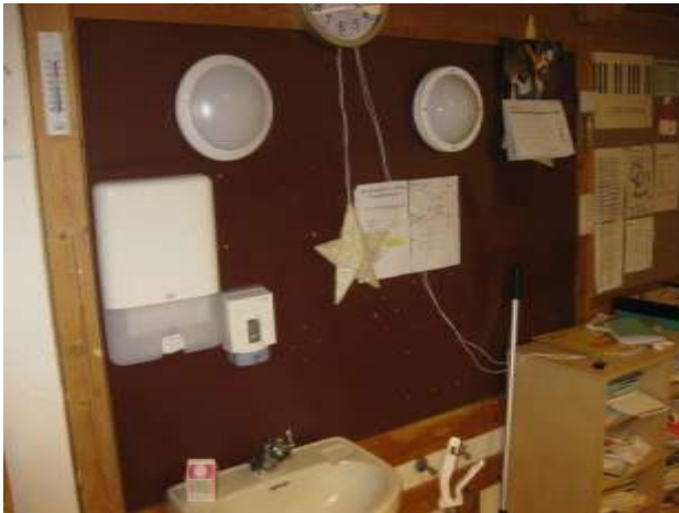
Bilde 34: Respatex plate på vegg. Ordinært avfall
