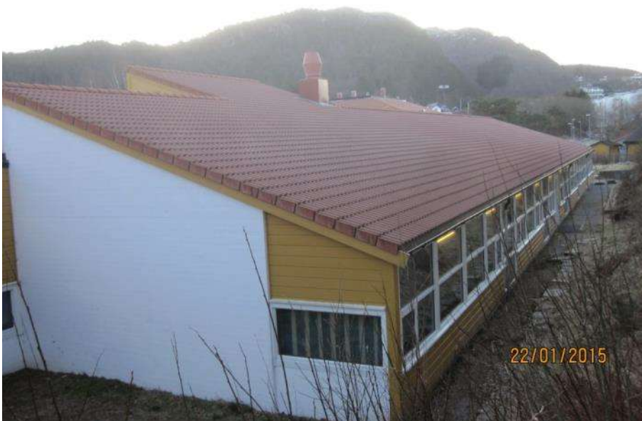
Bilde 4: Fasade mot vest
