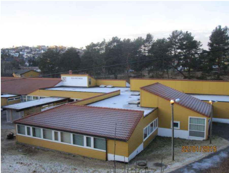
Bilde 3: Fasader mot nord, øst. Administrasjon
