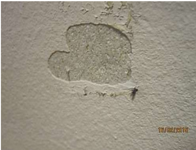
Bilde 5: Viser overmalt veggplater av 12 mm pernit. Typisk innervegger i hele bygningen.
