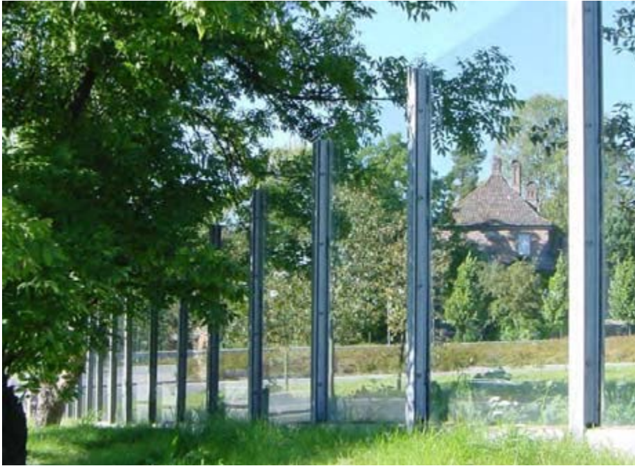
Bilde: Forslag til støyskjerm med herdet glass langs Åslia
