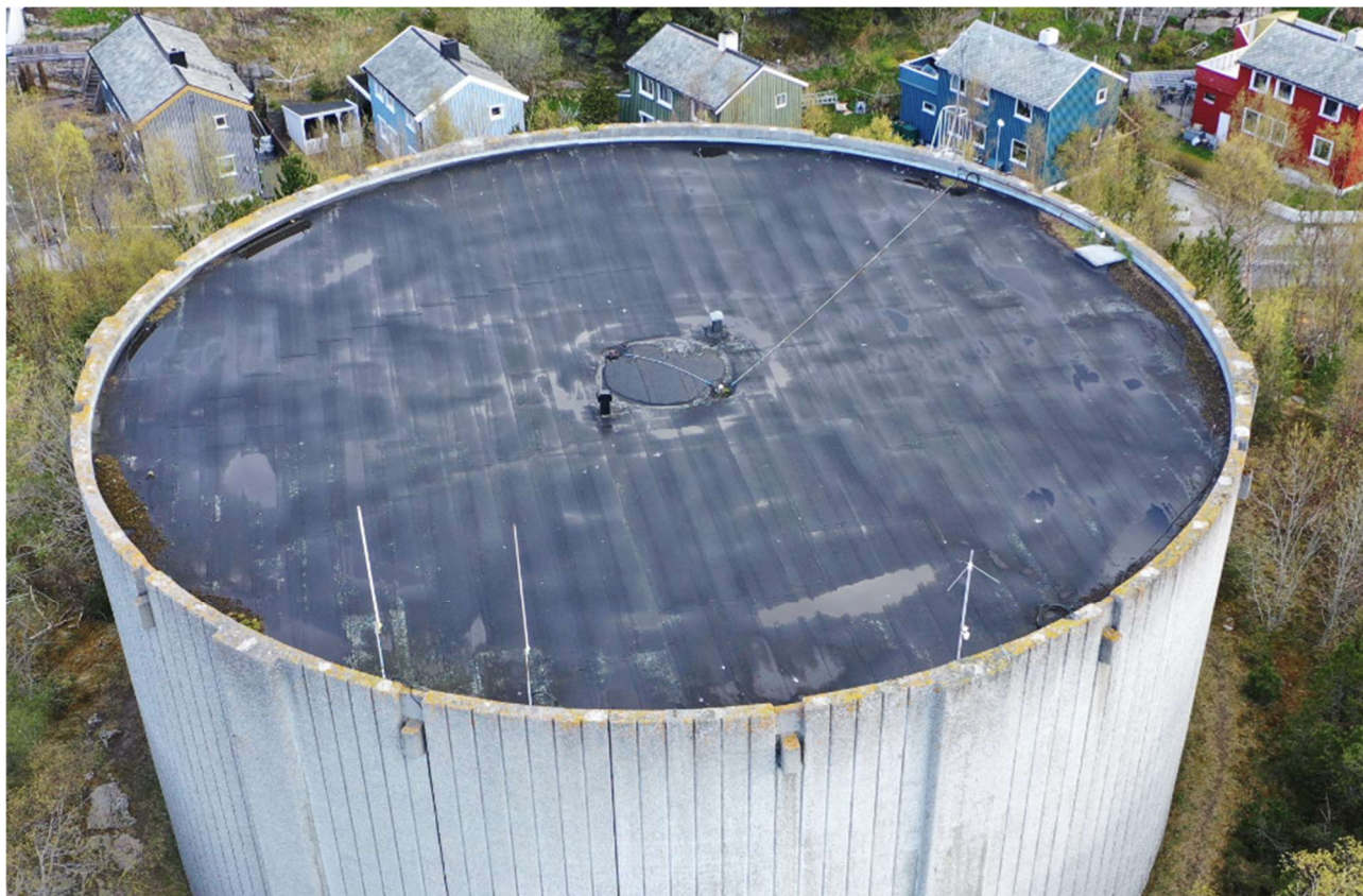
Figur 2 - Oversiktsbilde av taket
