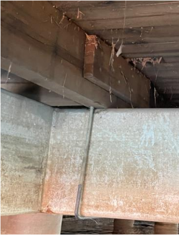
Bilde 2: Trebjelker festet til stålbjelker med hakbolter
