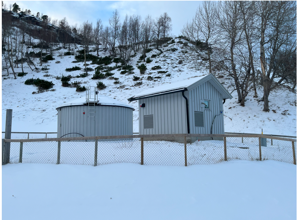
Figur 1 Misvær vannbehandlingsanlegg med rentvannsmagasin
