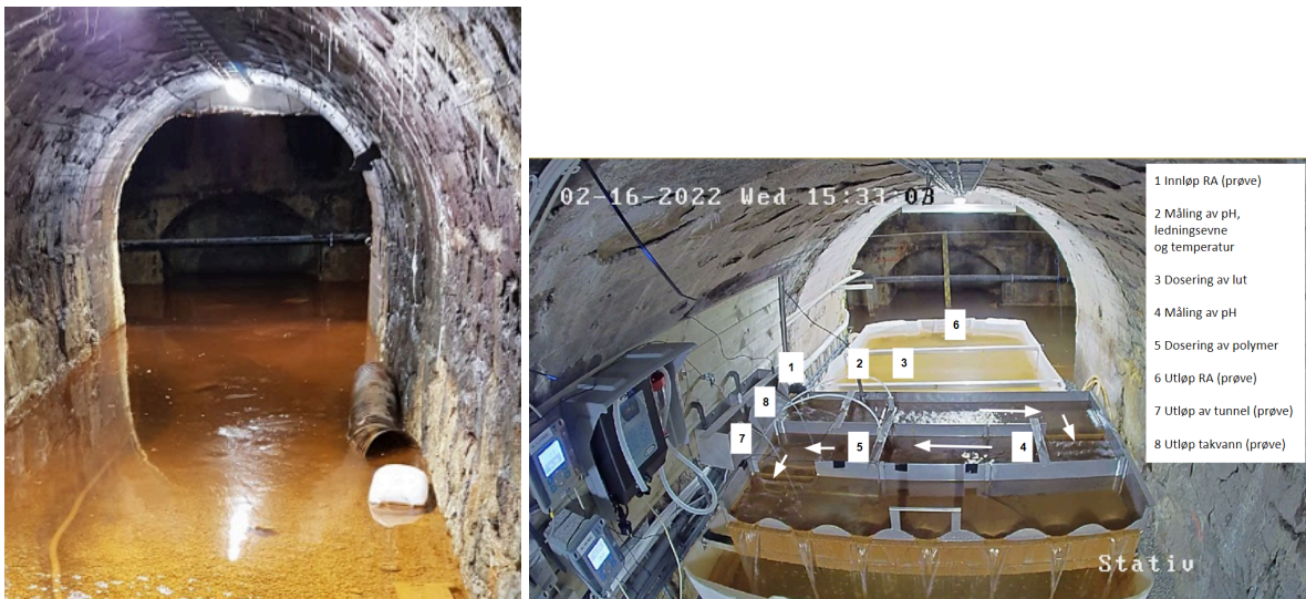
Figur 4: Innsiden av tunnelen med midlertidig rensanlegg
