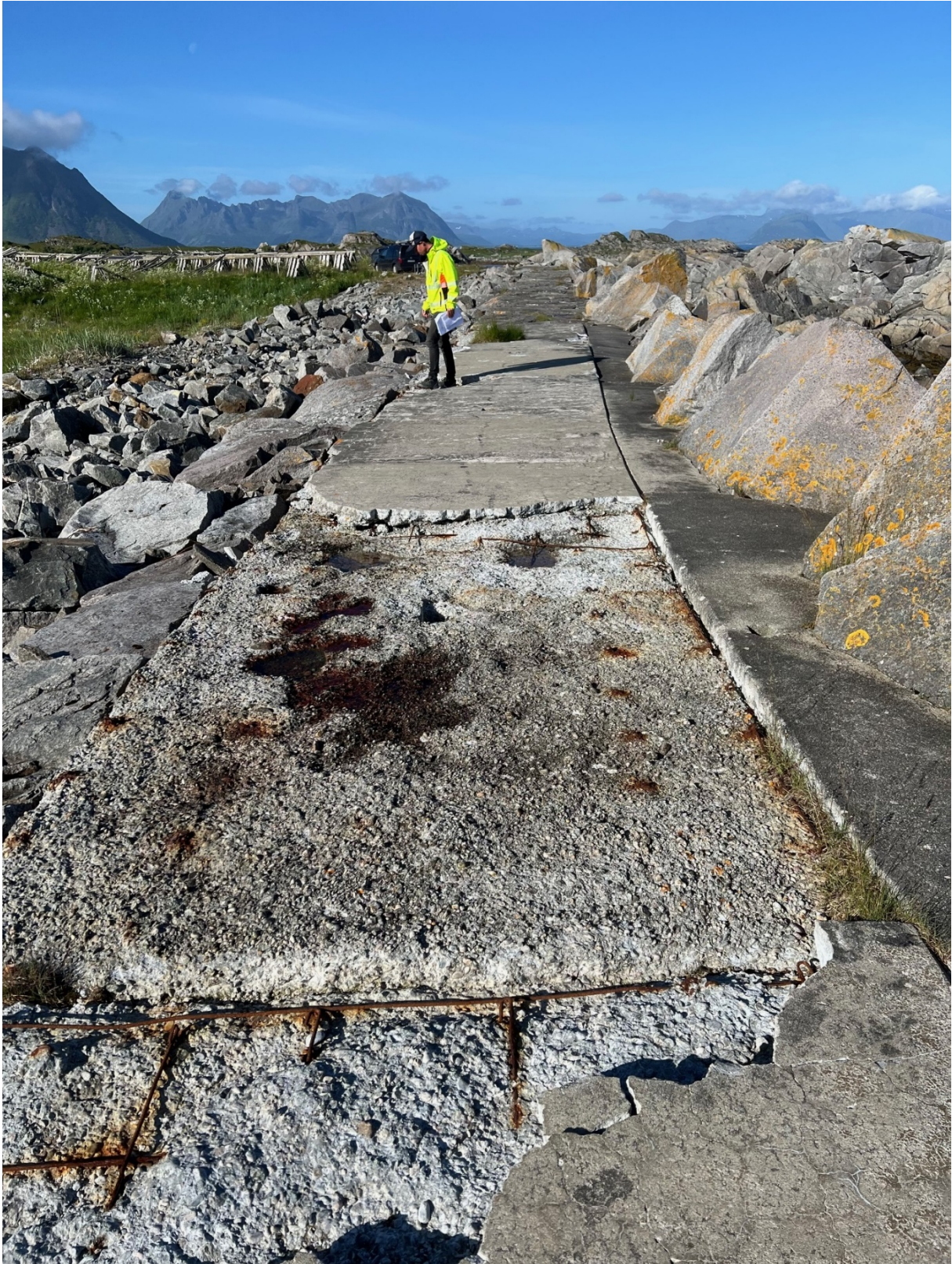
Figur.8.Skade.på.eksisterende.molodekke
