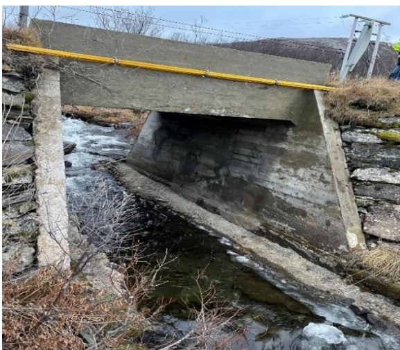
Figur 4: Under eksisterende bru, tatt fra nedstrøms side.
