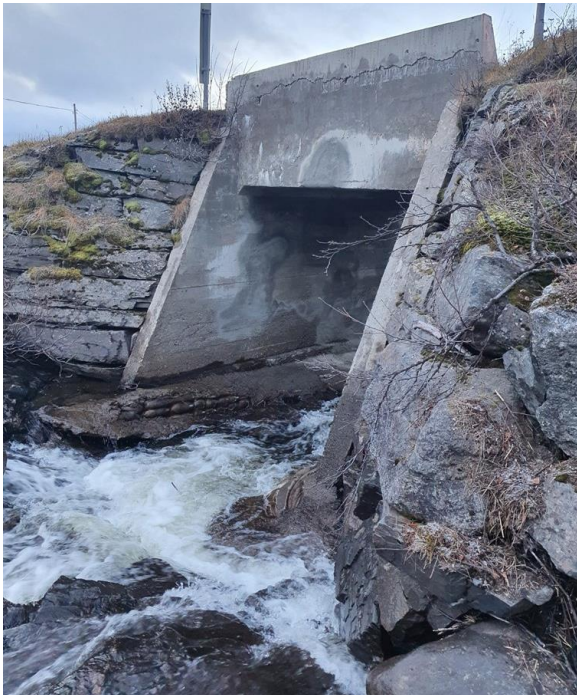
Figur 2: Bilde av eksisterende bru fra oppstrøms side.
