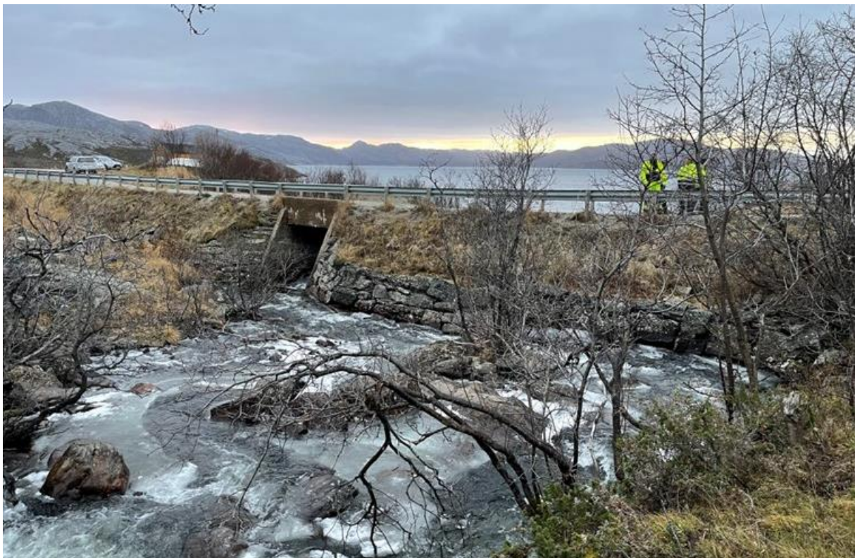
Figur 2: Bilde av eksisterende bru fra oppstrøms side der elva renner parallelt med veien rett oppstrøms brua.
