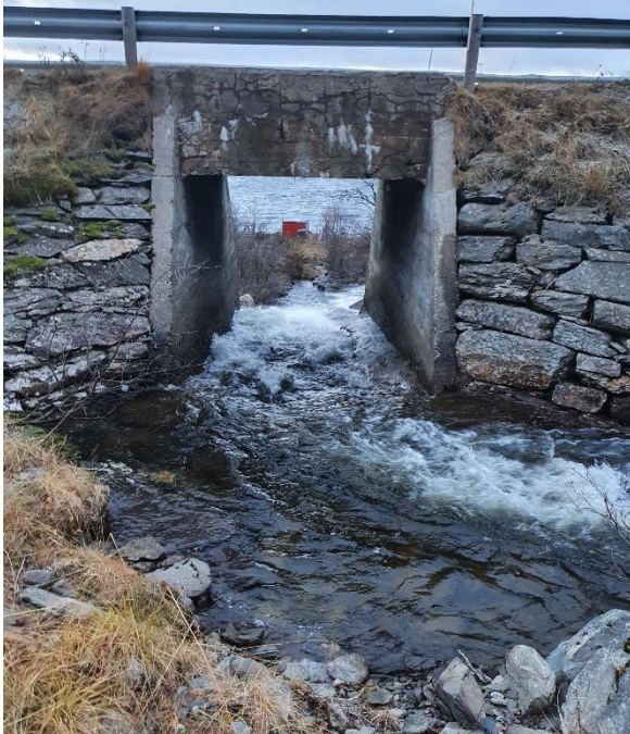
Figur 3: Rett oppstrøms dagens bru.
