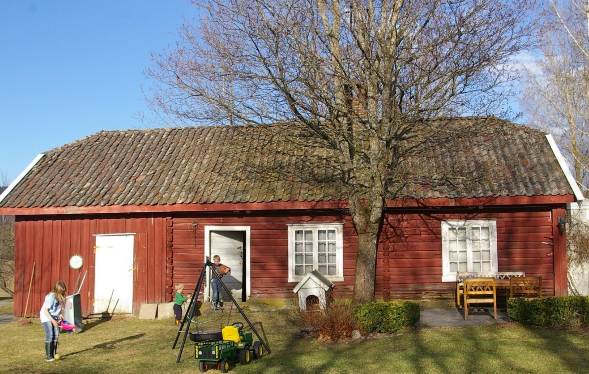
Åby, Frogner, Lier kommune. Bryggerhuset skårer høy på autentisitet. Bygningens hovedform og de alle fleste bygningsdelene er bevart. Foto: Jørn Jensen, Buskerud fylkeskommune
