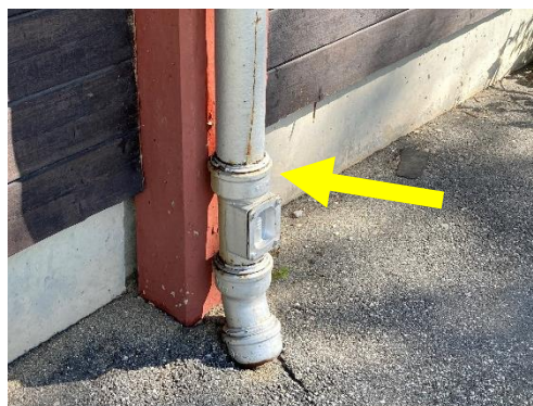
Figur 1 Gammelt avløpsrør av støpejern. Pilen viser plassering av eventuell asbestholdig tettemasse. Det er kun denne typen støpejernsrør vi kjenner til at det kan være brukt asbest i. Det er imidlertid ikke uvanlig at rørene er malt utenpå.
