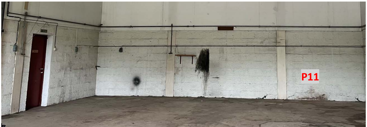
Figur 30: Bilde av umalte og malte Leca-vegger i verkstedet. Prøve P11 ble tatt av hvit maling på Leca-vegger.
