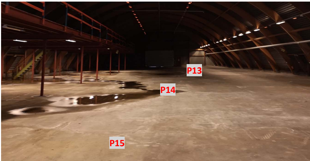
Figur 29: Bilde av betongdekket i lagerhallen. Prøve P13–P15 ble tatt fra ulike deler av betongdekket.
