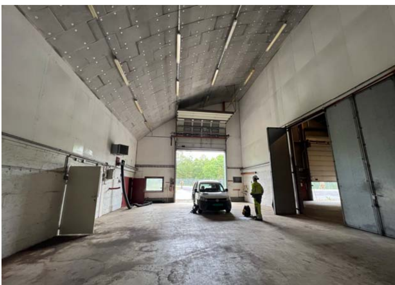
Figur 6: Innvendig i verkstedet. Døren som står åpen til venstre i bildet leder inn til ventilasjonsrommet. Foto er tatt mot nordøst. Foto: Multiconsult.
