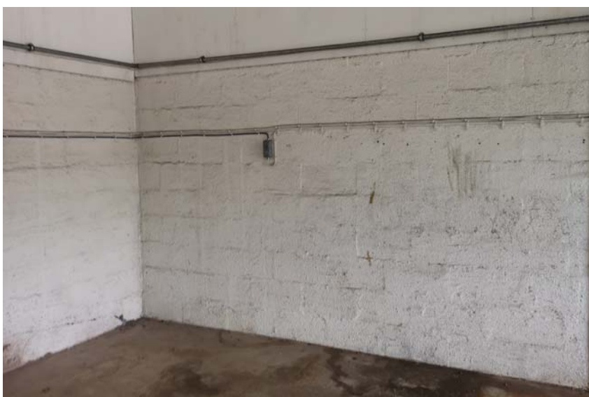
Figur 23: Hvit maling på Leca-vegg i verksted. Prøve P11 ble tatt av malingen. Det ble ikke påvist PCB eller tungmetaller over grensen for farlig avfall i malingen.
