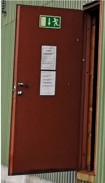
Figur 14: Branndør fra 1985. Døren inneholder ikke asbest.
