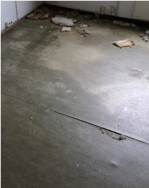
Figur 20: Linoleumsbelegg på gulv i andre etasje i kontordelen.
