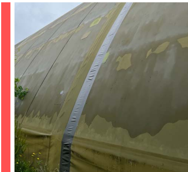
Figur 17: Takduk på lagerhall. Duken inneholder ftalater over grensen for farlig avfall.
