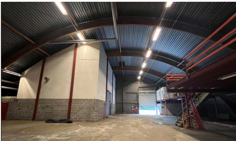
Figur 5: Innvendig i lagerhallen. Mesaninen sees som rød konstruksjon til høyre i bildet. Verkstedet ligger bak de hvite veggene. Foto er tatt mot nordøst. Foto: Multiconsult.
