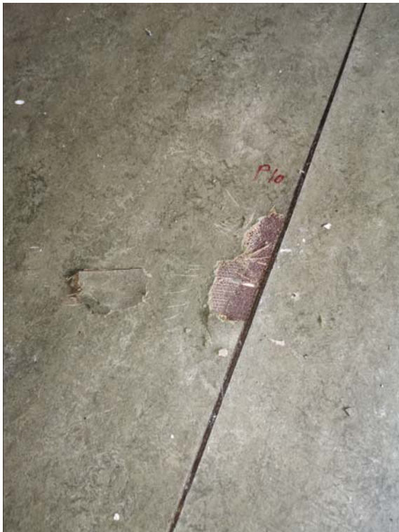
Figur 13: Linoleumsbelegg på gulv i andre etasje i kontordel. Det ble ikke påvist asbest i gulvbelegget.
