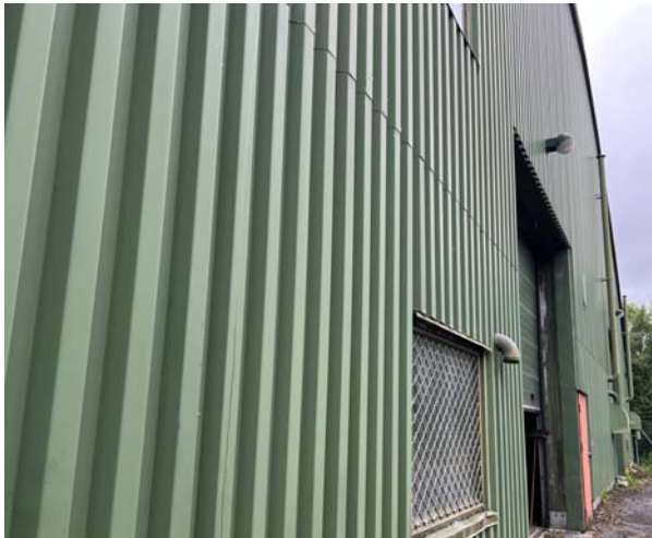
Figur 22: Grønnmalte stålplater på fasader på lagerhall.
