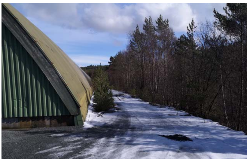
Figur 9: Prøvetakingspunkt P5 ble tatt som en blandeprøve av massene ned til 0,2 m dybde langs sørfasaden på COB-hallen. Foto er tatt mot nordøst. Foto: Multiconsult.
