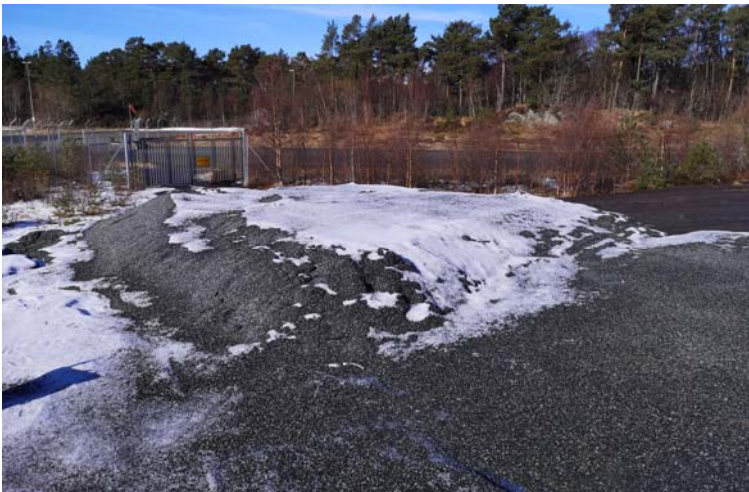
Figur 4: Arealet hvor renseanlegget lå oppå sandmassene. Foto er tatt mot vest. Foto: Multiconsult.
