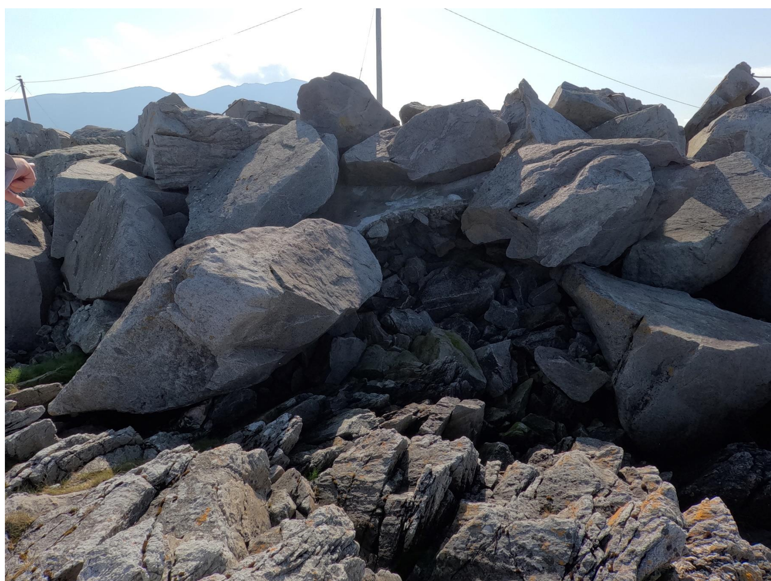
Figur 15: Stor blokk har flyttet på seg og eksponert kjernemasse.
