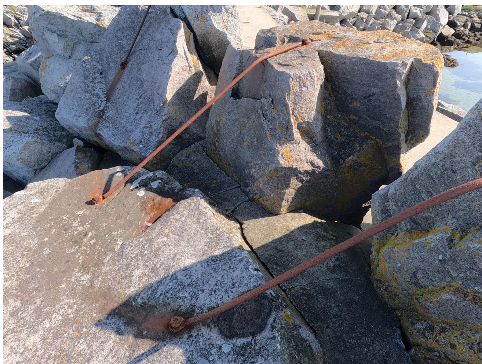
Figur 16: Rust på klammerjern.
