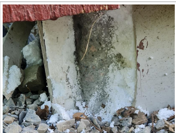
Bilde 11: Observert EPS isolasjon i grunnmur i tilbygg fra 2008.
