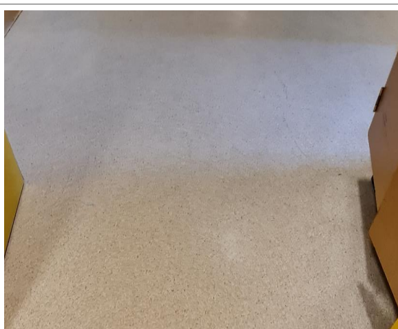
Bilde 10: Vinylgulvbelegg i tilbygg fra 2008.
