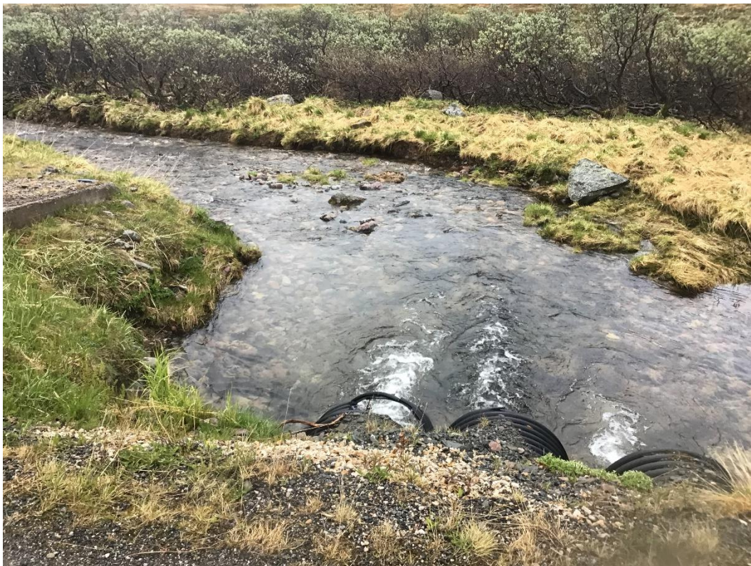
Figur 6. Utløp og kulp nedstrøms veg. Brekket som definerer kulpen ligger ved de nærmeste steinene som stikker opp av vannet. Kulpen er ett av de breieste partiene i nedre del av elva, med ca. 6 m bredde.
