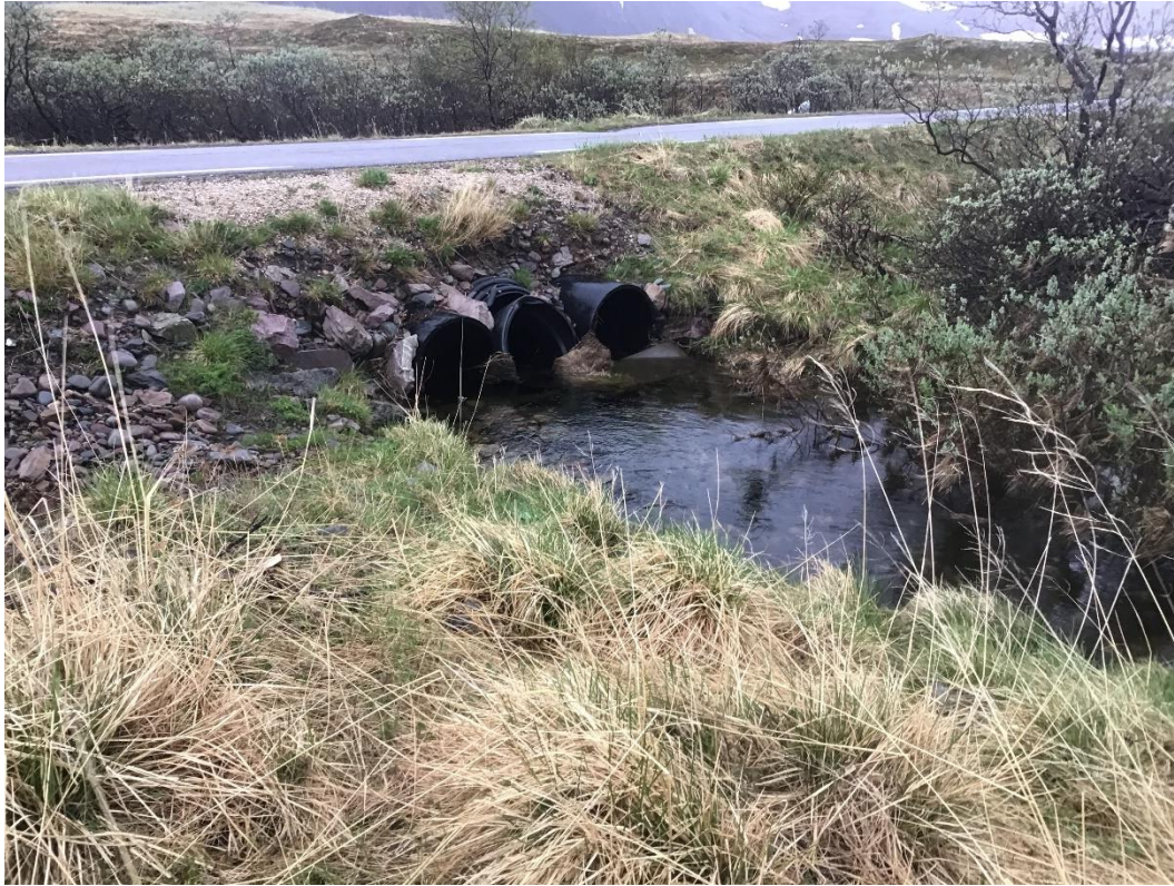
Figur 7. Oversiden av veg og rør. Bekken har en bredde på ca. 3 meter her. Løpet videre oppover er stort sett litt smalere enn dette.
