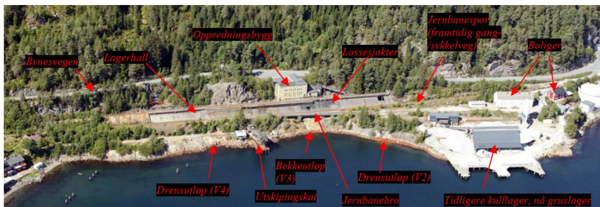
Figur 2 Oversiktsbilde før tildekking (Multiconsult 2009)
