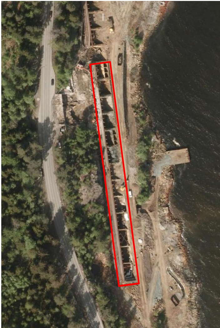
Figur 1: Flyfoto av Killingdalområdet under opprydding i 2010. Lagerhall/lossesjakter er merket med rødt. (Kilde: finn.no)
