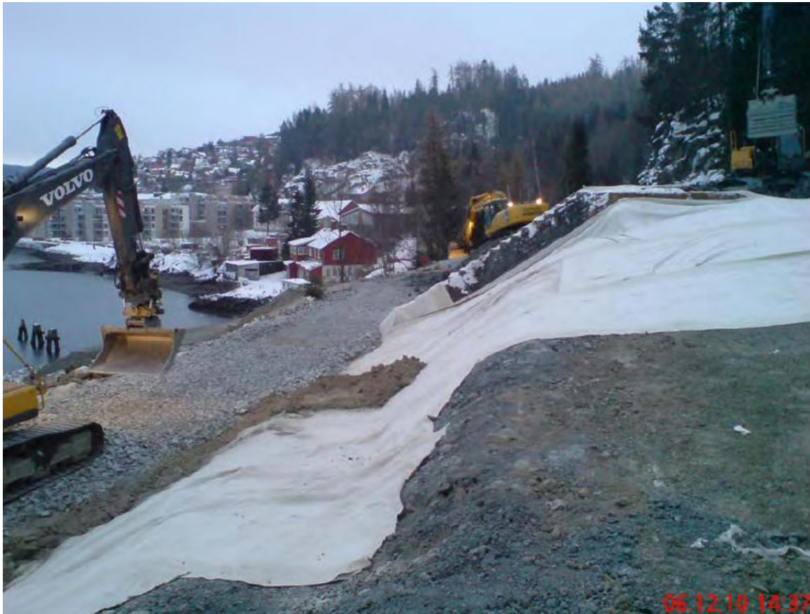
Figur 11 Membranlegging på deponiet over lagerhallen, og i framtidig gang-/sykkelvei (MC 2010)
