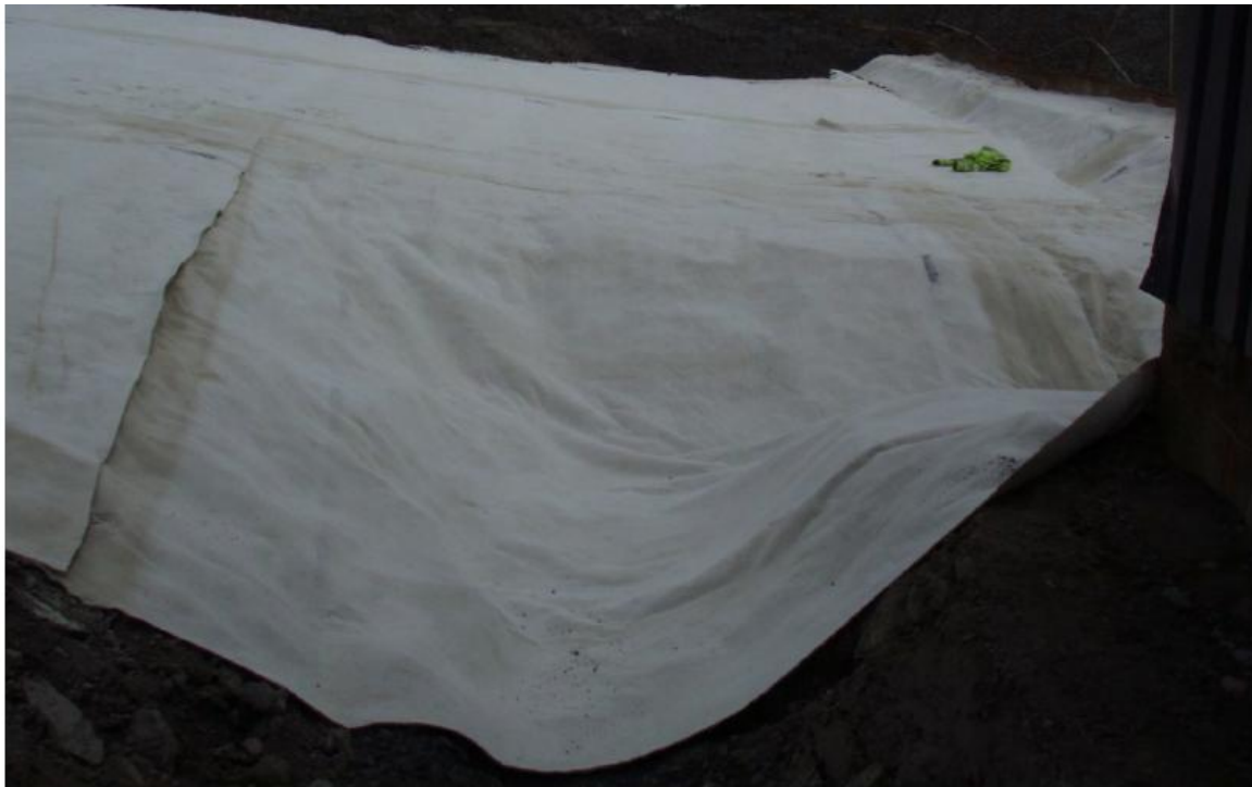
Figur 17 Det er etablert grøfter som membranen er ført ned i, og siden lagt drensør. Nordre del (MC 2010)
