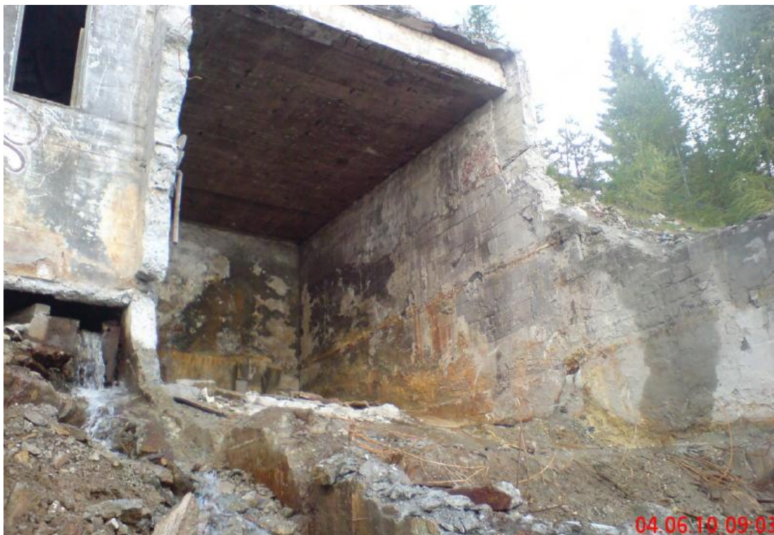
Figur 2 Killingdalbekken renner ut under det gamle hovedbygget (Multiconsult, 2010).
