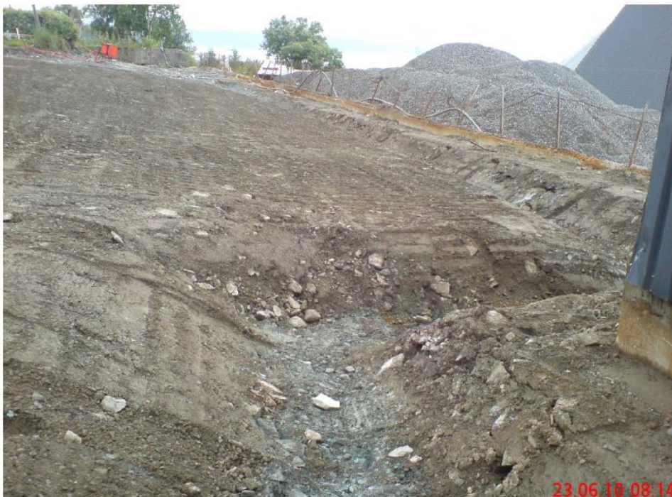
Figur 16 Det er etablert grøfter som membranen er ført ned i, og siden lagt drensør. Nordre del (MC 2010)
