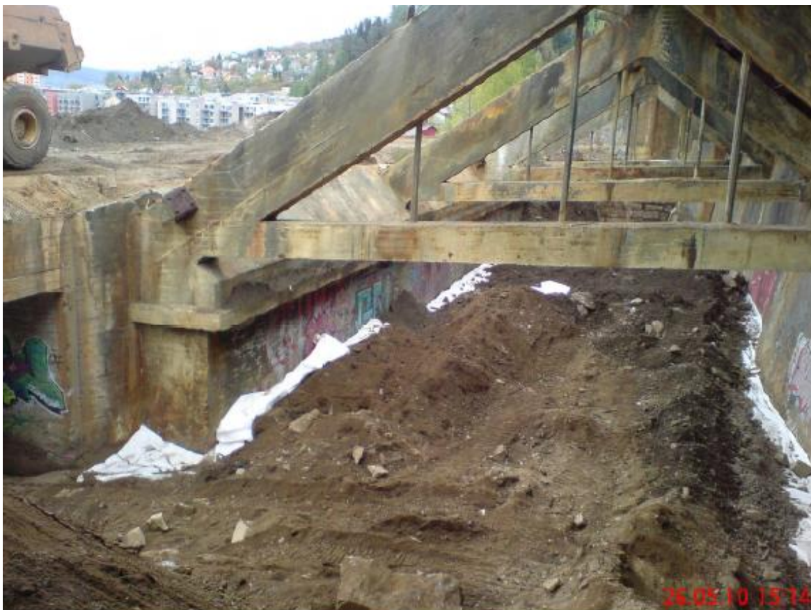
Figur 10 Innfylling av masser i internt deponi (Multiconsult, 2010).
