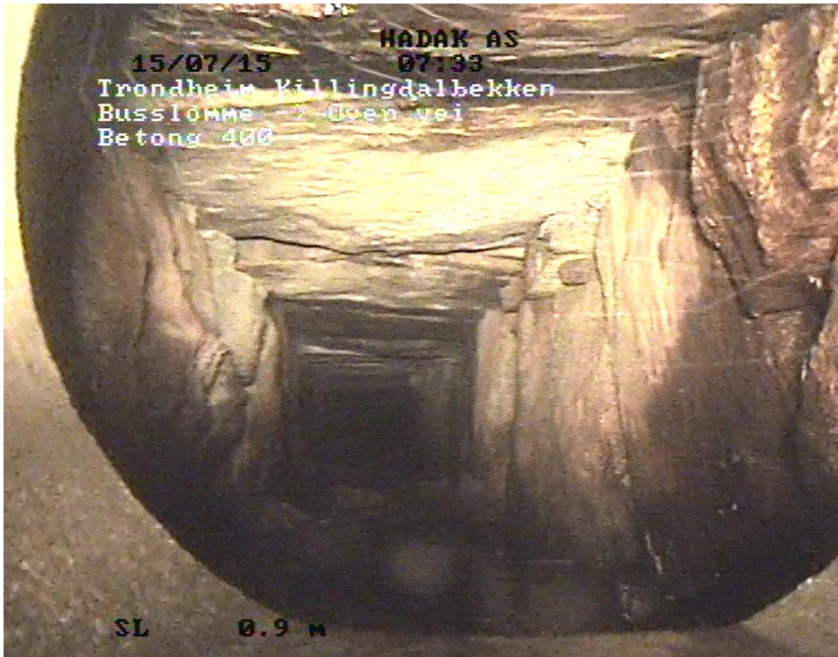
Figur 20 Bilde fra videoopptak av Killingdalbekken.
