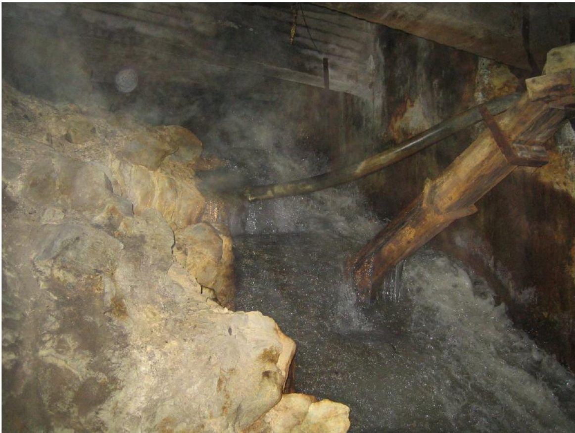
Figur 21 Killingdalbekken. Bekkeløpet er gjenfrosset lenger ned, og vannet gikk derfor til V2 i stedet for V3 (Multiconsult 11.3.2010)
