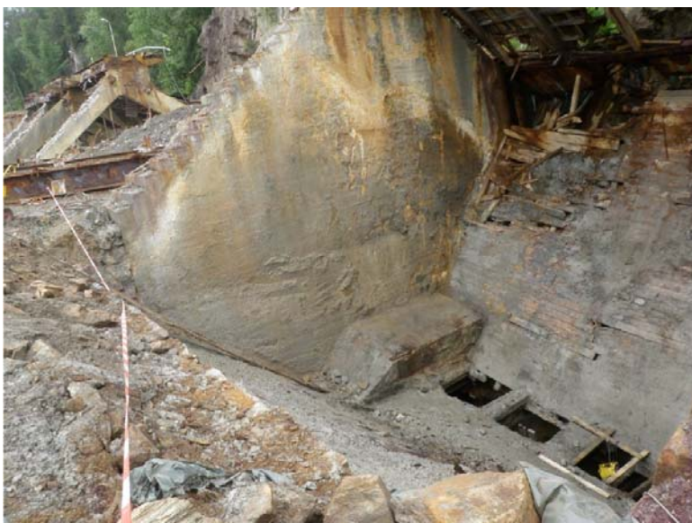
Figur 15 Foto fra saneringsfasen i 2010, som viser den sørligste av lossesjaktene, før tetting av lukene ned mot tunnelen og tilbakefylling med forurensede masser fra øvrige deler av området (opp til tilstandsklasse 4). I denne sjakta ble tetting utført med plasstøpt betongplate. De 11 sjaktene hadde ulik utforming, også i bunnen ned mot tunnelen.
