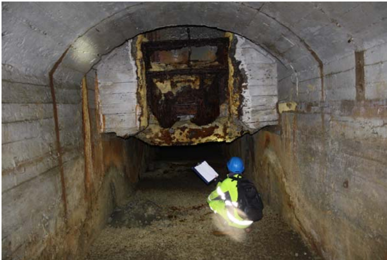
Figur 16 "Framsiden" av sjakt, med åpning for mating fra sjakt ned på transportbånd.
