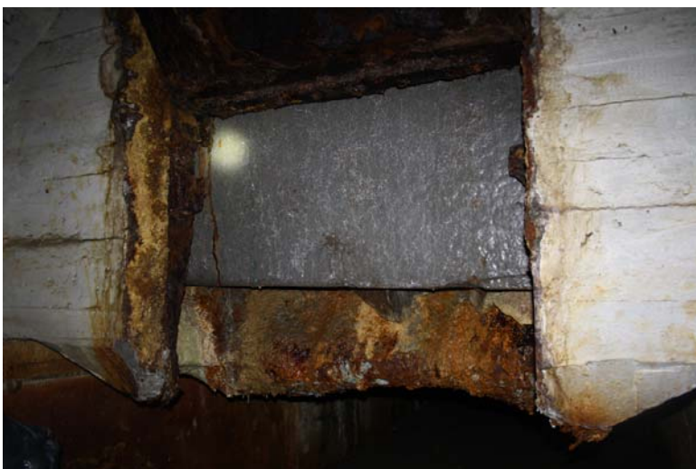
Figur 18 Foto som viser vertikalt betongelement som under saneringen ble montert i bunnen av hver av de 9 sjaktene som har denne utformingen, for å holde deponert materiale på plass.
