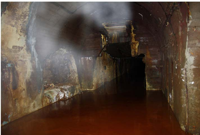
Figur 10 Dam fra adkomsttunnel og nordover (retning V2).
