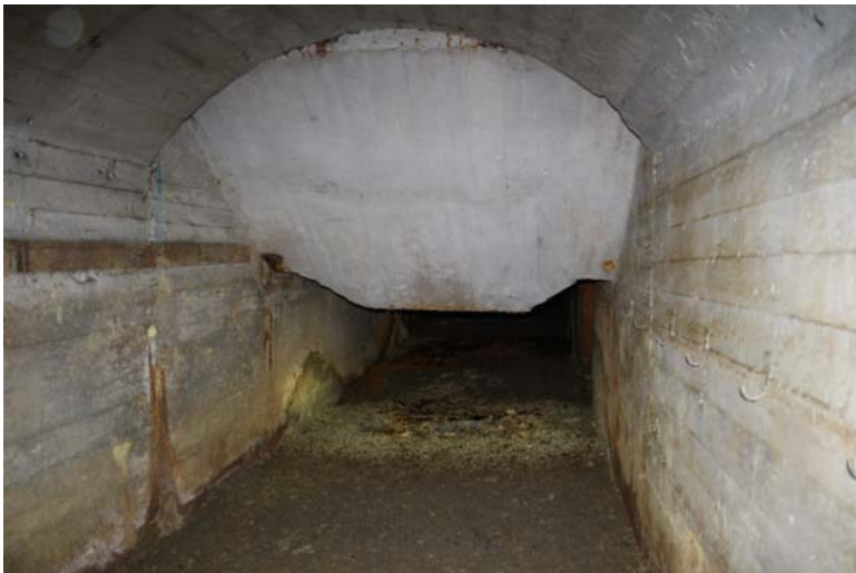
Figur 17 "Baksiden" av sjakt, bestående av skrå betongplate.
