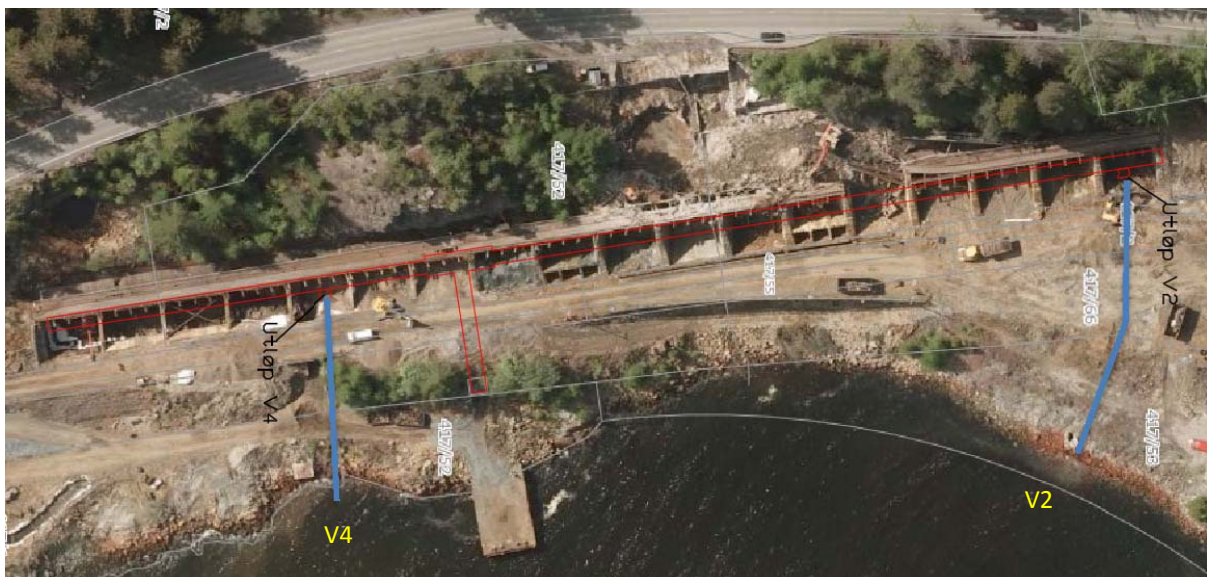
Figur 20 Tunnelssystem vist på flyfoto fra 2010, da sanering av området pågikk.
