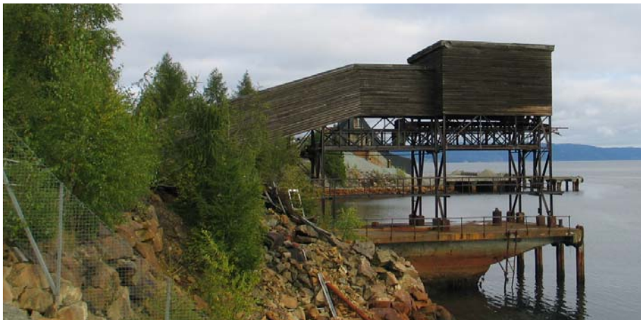
Figur 15 Utskipingskai med overbygd transportbånd.
