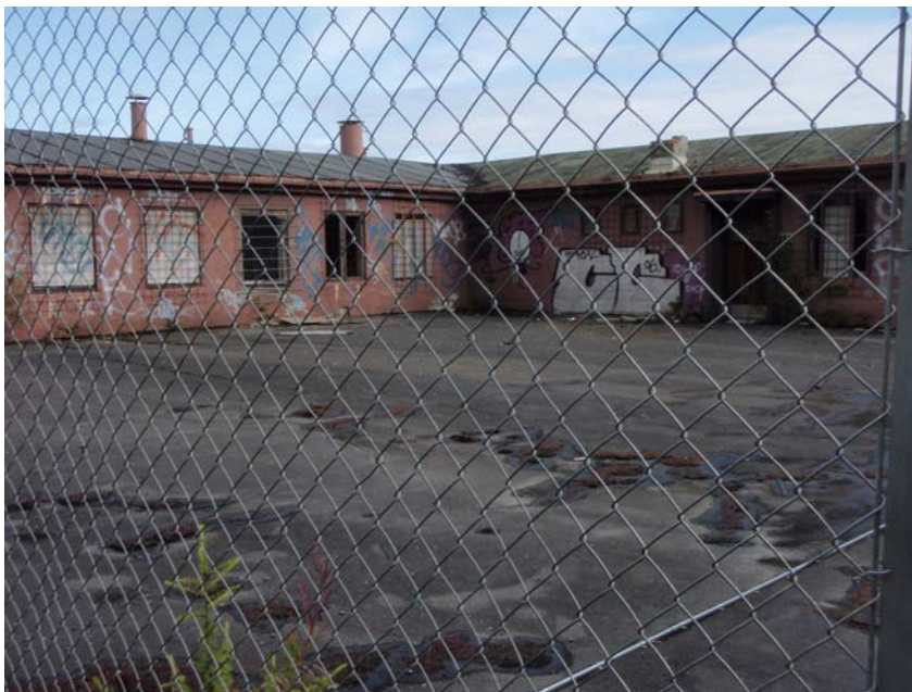
Figur 11 Deler av fasader opp mot Bynesvegen (mot vest). I forgrunnen er taket over ”nye flotasjonshallen”, som flukter med Bynesvegen.
