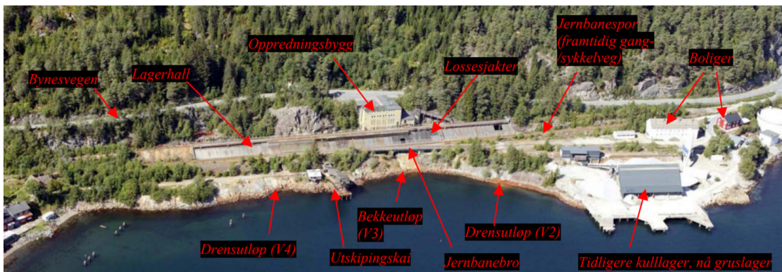
Figur 1 Oversiktsbilde over Killingdal Oppredningsverk før sanering. Venstre side er i retning sør, høyre side er mot nord.
