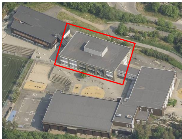
Figur 5: Havlimyra oppvekstsenter sett fra sør.
