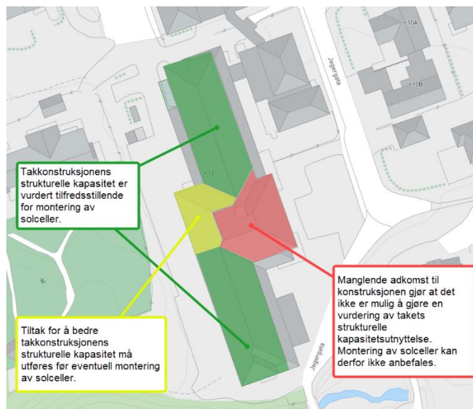
Figur 2: Takarealer egnet for montering av PV-moduler på Grimtunet omsorgssenter
