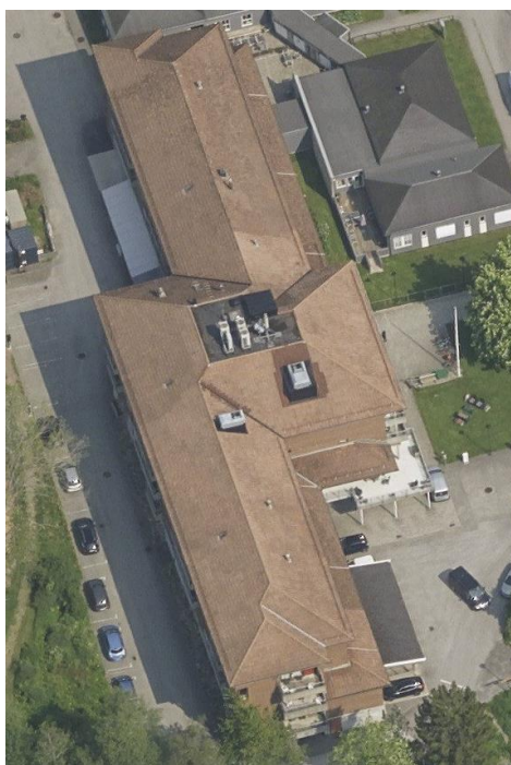
Figur 1: Grimtunet omsorgssenter sett fra sør.
