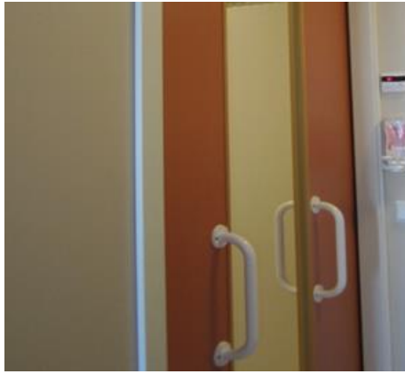
Håndtak vist på bildet vil kreve en større lysåpning for å få tilstrekkelig passasje. Foto: Husbanken
