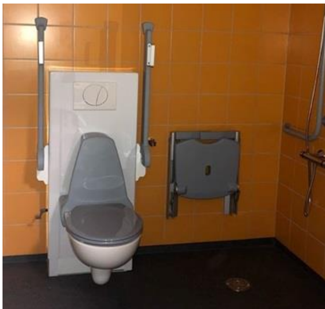
Her vises ryggstøtte til bruk på dype vegghengte toalett. Det er bra kontrast mellom utstyr og vegg og mellom gulv og vegg. Foto: Husbanken
