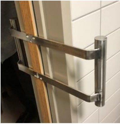
Skyvedører med håndtak som tillater full lysåpning. Foto: Husbanken
