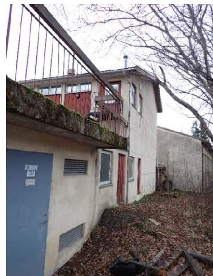
Figur 8 Fasade mot nord - opprinnelig del. Trafo til venstre.
