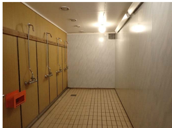
Figur 12 Dusj i opprinnelig del.
