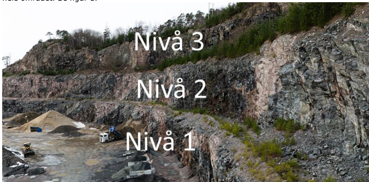
Figur 1: Skisse som illustrerer nivådeling av bergskjæringen.
