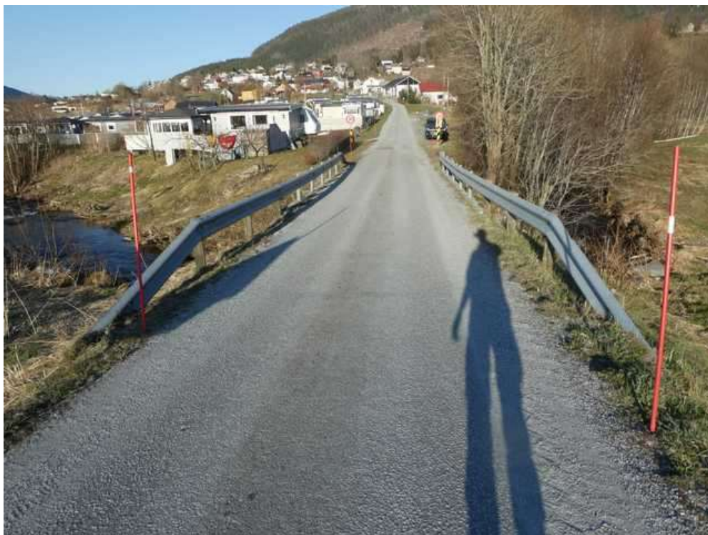
Bilde 2: Oversiktsbilde sett over brua
