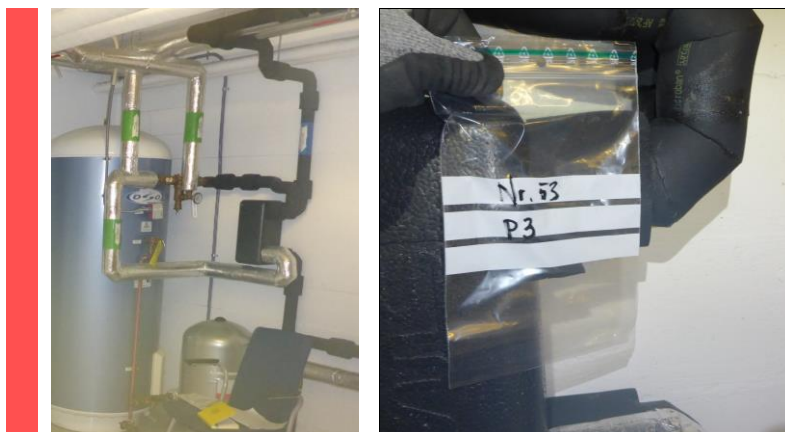
Figur 26 Eksempel på cellegummi i rom 008/vifterom i kaserne 53. Det er påvist bromerte flammehemmere i prøvetatt materiale ( P3 ).
