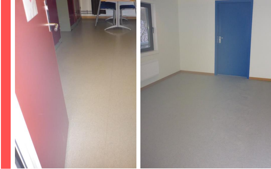
Figur 16 Eksempler på vinylbelegg i kaserne 52. T.v. Vinylbelegg i rom 103/sengerom. T.h. Vinylbelegg i rom 308 på loftet. Det antas at begge vinylbeleggene inneholder ftalater.
