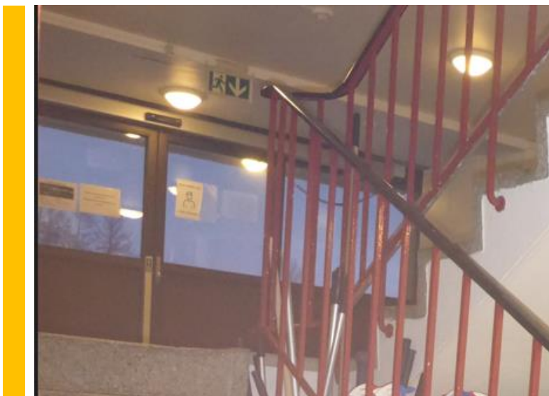
Figur 15 Nyere isolerglassruter i inngangsparti i kaserne 53.
