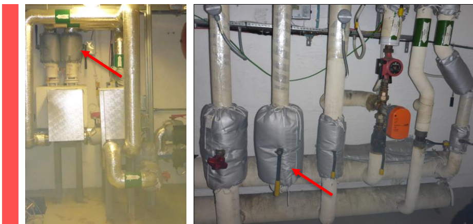
Figur 27 T.v. Eksempel på PVC-duk på rør i rom 012 i kaserne 52. T.h. Eksempel på PVC-duk på rør i rom 008/vifterom i kaserne 53. PVC-duk leveres til godkjent mottak som farlig avfall mhp. ftalater.
