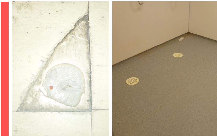
Figur 17 Eksempler på vinylbelegg i kaserne 53. T.v. To lag med vinylbelegg i rom 116/oppholdsrom. T.h. Vinylbelegg i rom 126/dusjrom. Det antas at alle vinylbeleggene inneholder ftalater.
