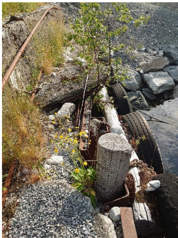
Figur 8: Bilde av telefonstolpe, spunt, bildekk og betong ved kaianlegget i Matre (foto: Rambøll).
