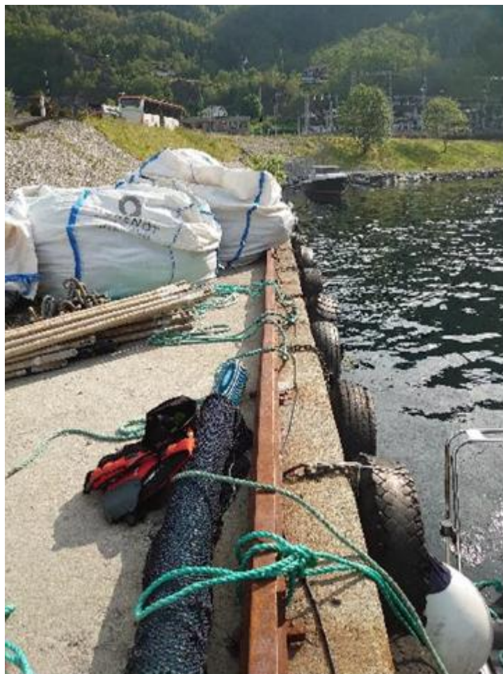
Figur 1: Kai i Matre. Plasstøpt betongplate med jernbaneskinne i front (Foto: Rambøll /1/).
