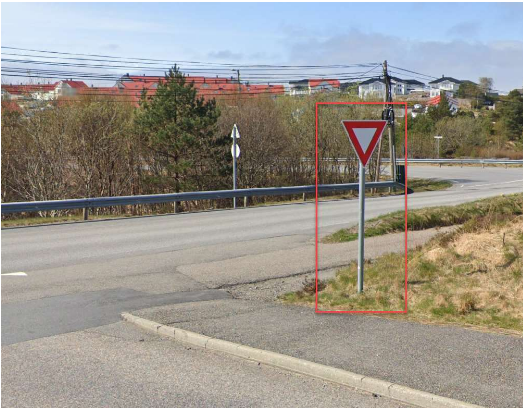
Figur 8: Viser vikepliktsskilt som må flyttes
