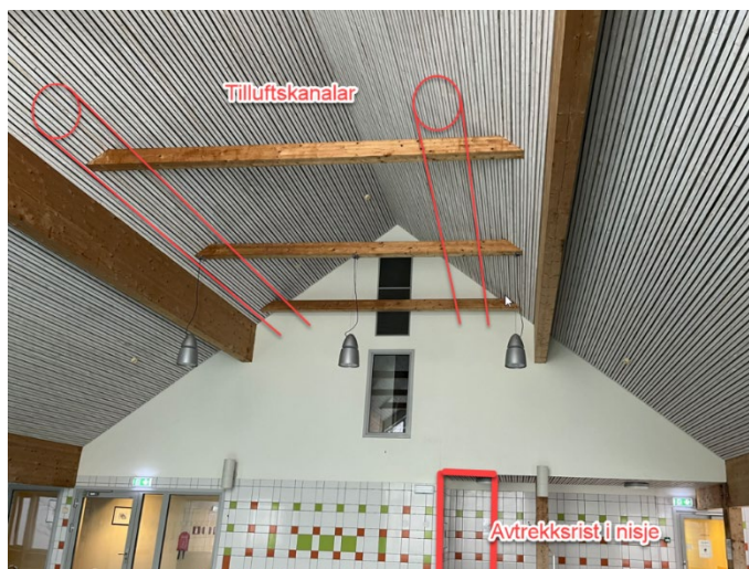
Figur 36-2 Tilluft og avtrekk i svømmehall, forslag
