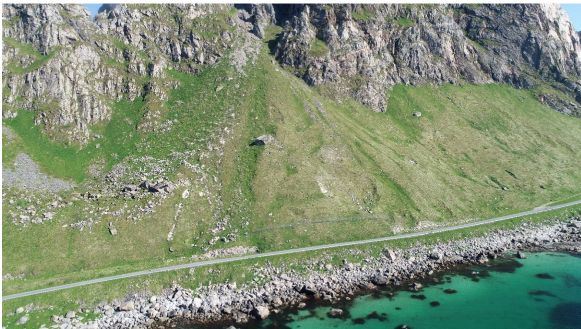
Figur 1. Oversiktsbilde. Eksisterende steinspranggjerde vises mellom murene.
