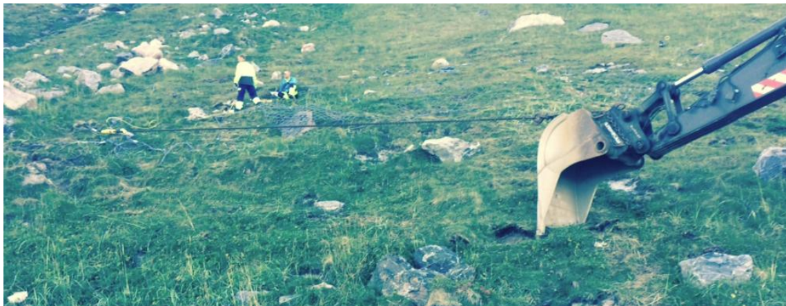
Figur 1: Bildet viser oppsett for prøvetrekking av anker med bruk av trykksylinder og gravemaskin
