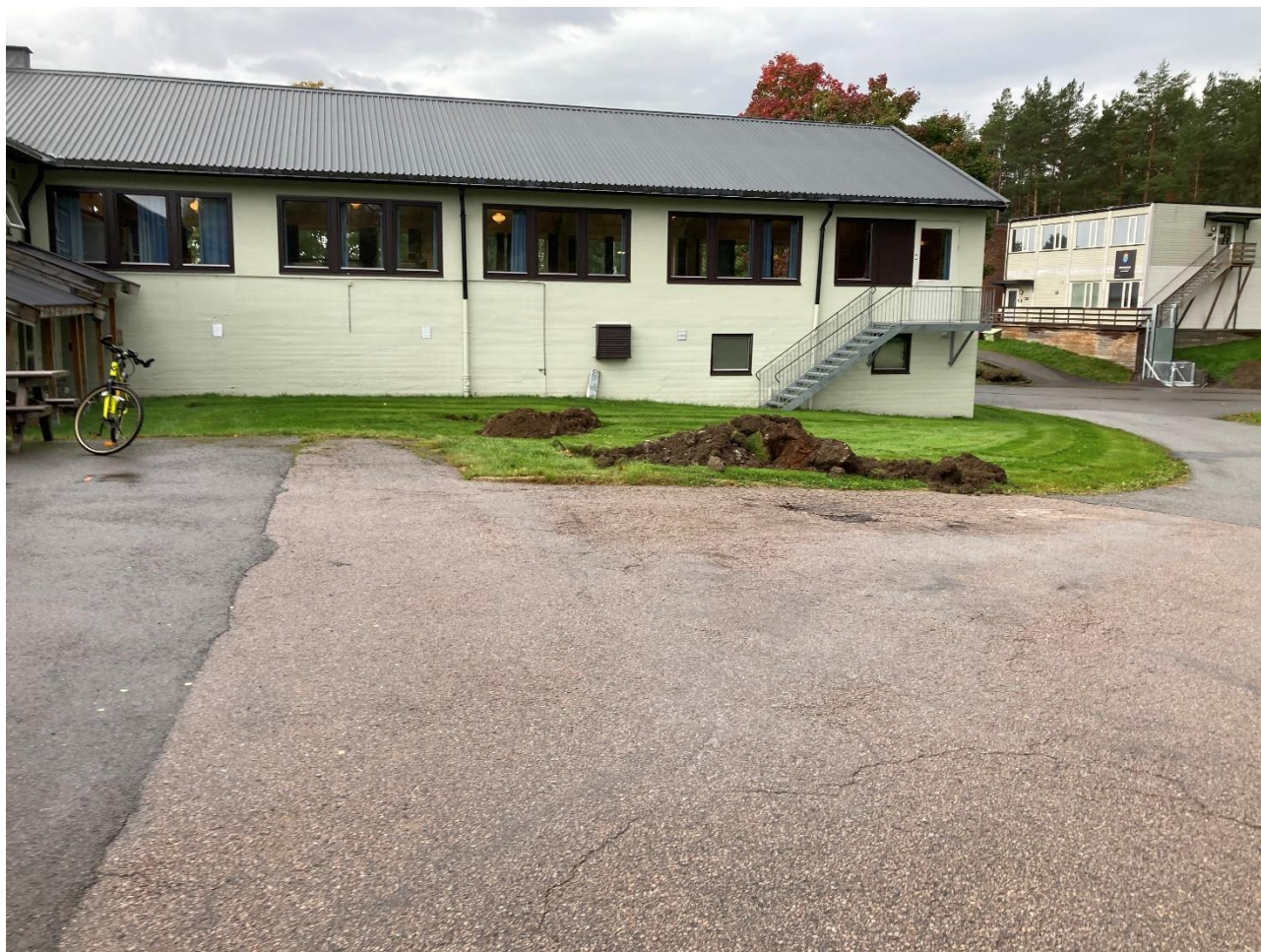
Figur 4: Tiltaksområde ved kjøkken
