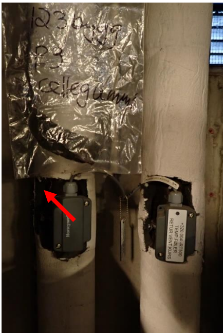
Figur 6 Cellegummi prøvetatt ( P3 ) i rom 202/VVS inneholder bromerte flammehemmere over grensen for farlig avfall .
