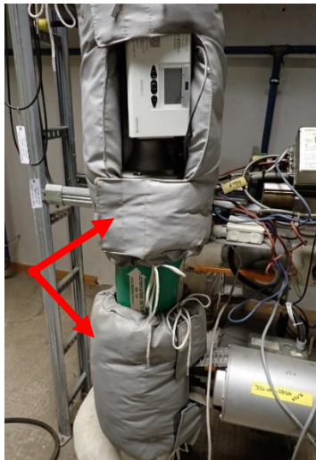
Figur 4 PVC-duk i rom 107/VVS antas å inneholde ftalater over grense for farlig avfall , og skal ved eventuell sanering sorteres ut og leveres til godkjent mottak.
