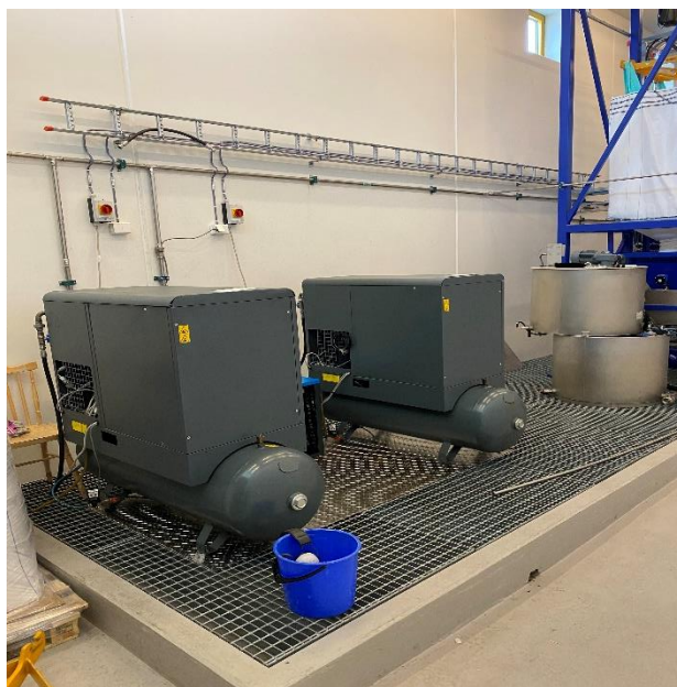
Eksisterende kompressoranlegg som må flyttes.
