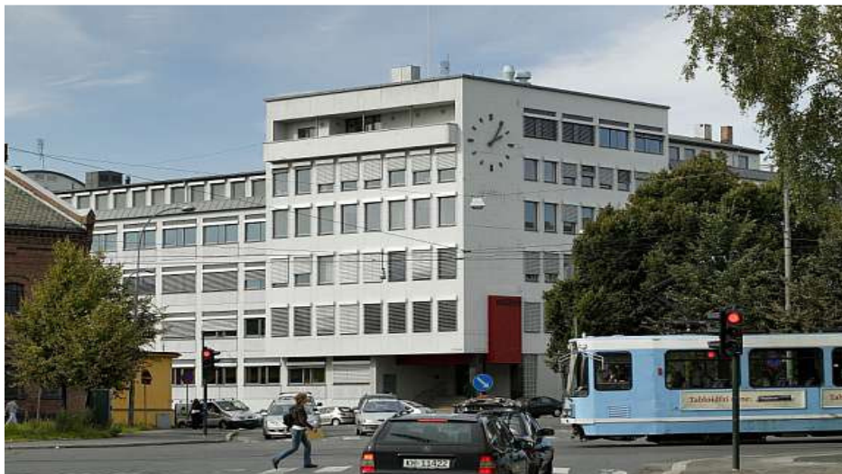
(Bilde: Patentstyrets kontorbygg i Sandakerveien 64)
