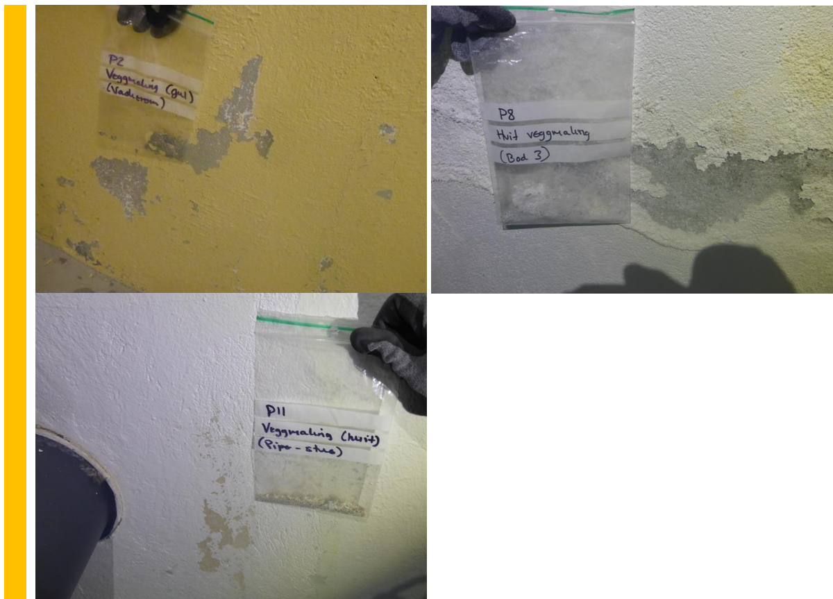
Figur 16 Maling på betongvegg, inneholder ikke farlig avfall.
