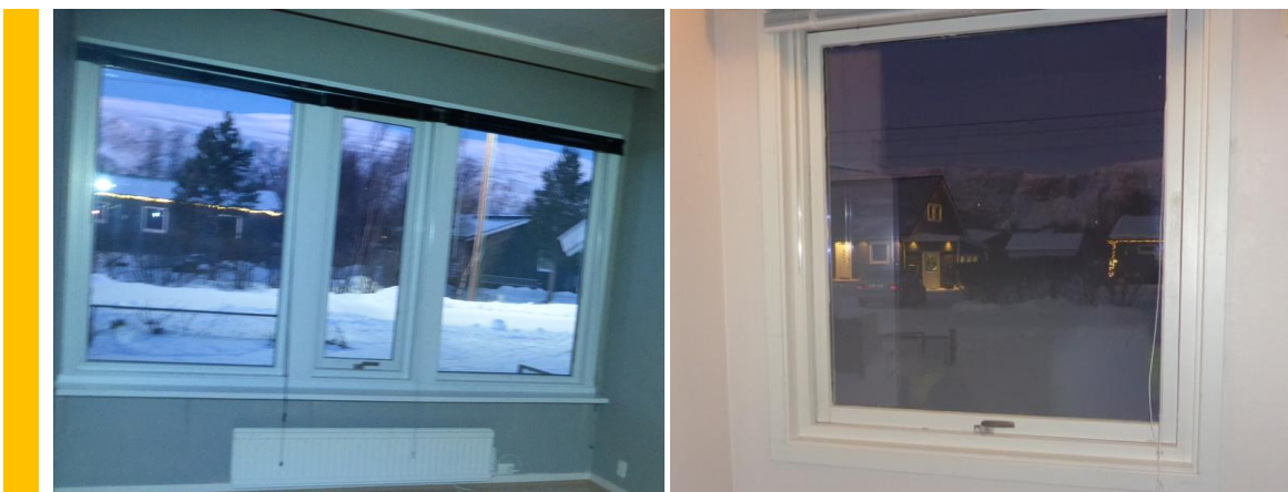
Figur 11 Nyere isolerglassruter i stuen, soverom og kjøkken.
