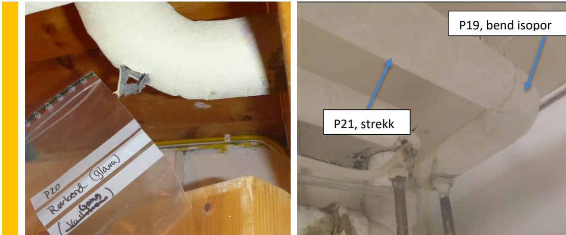
Figur 8 Rørbend med glassvatt og isopor, samt rørstrekk ble analysert for asbest. Det ble ikke påvist asbest.
