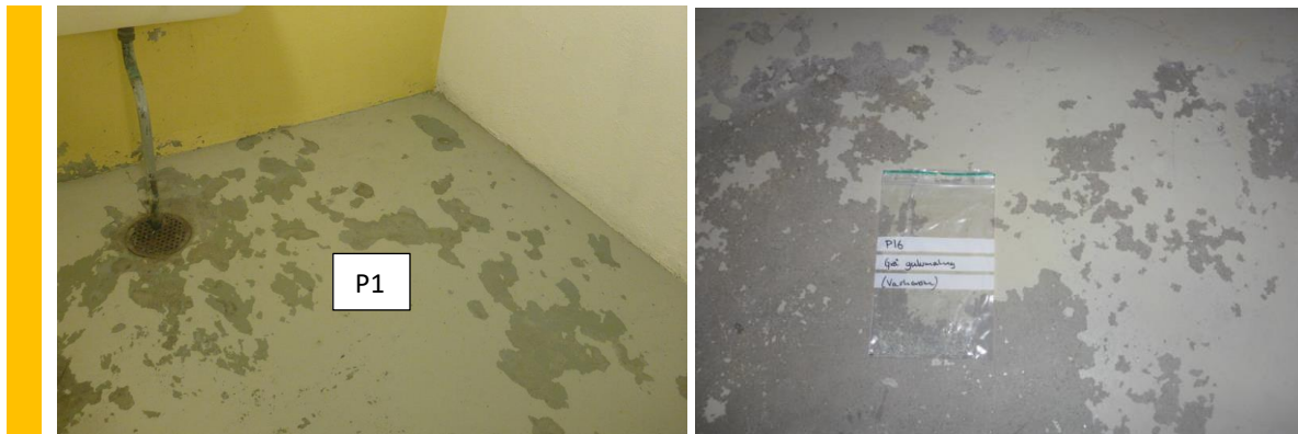
Figur 15 Malingen på betonggulvet på kjellerne (med unntak av bod 005 og 007) inneholder ikke farlig avfall av PCB eller tungmetaller.
