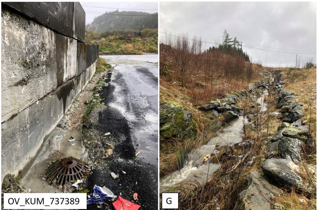
Figur 3-6: Til venstre overvannskum 737389. Til høyre prøvepunkt i åpen bekk til Mjølkevika er plassert like ved OV_KUM436717.
