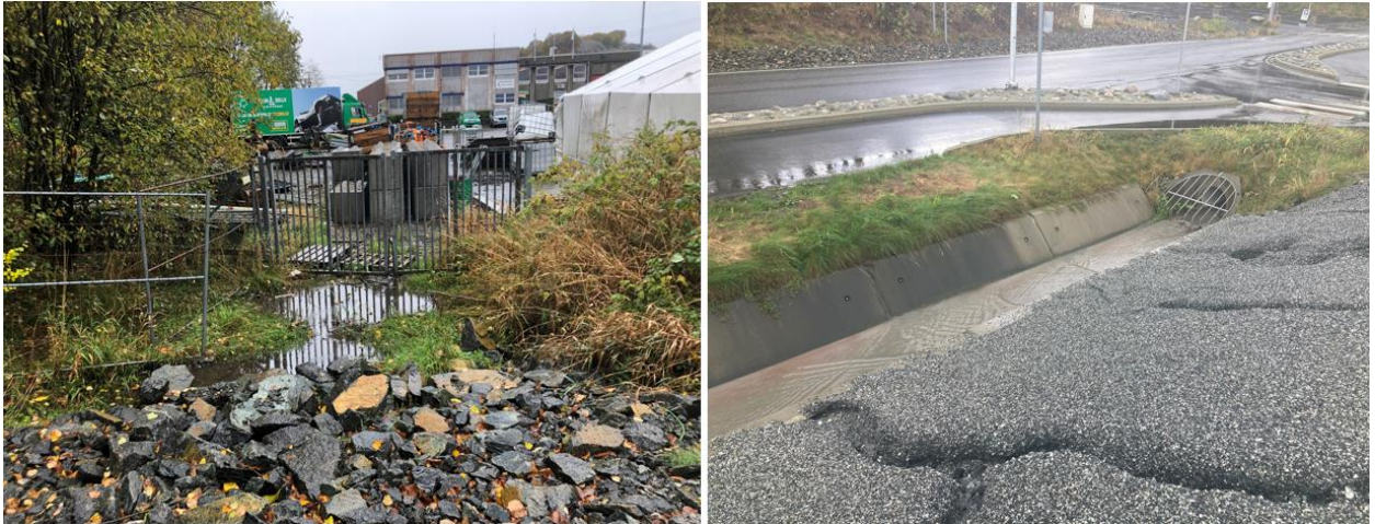
Figur 3-5: Til venstre ses dam ved Ragn Sells, overflatepunkt C. Til høyre overflatepunkt D.
