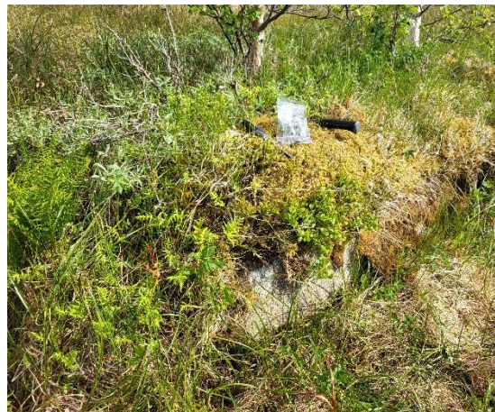
Figur 13. Støttemur i betong, MP2.
