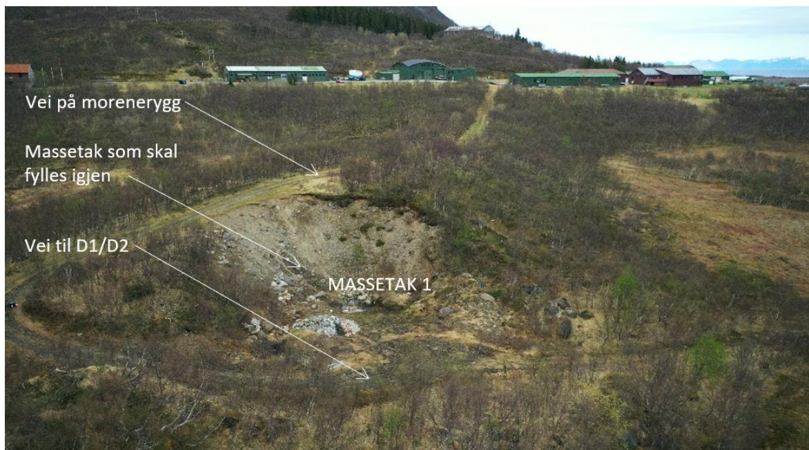
Figur 5-57: Massetak 1 sett mot nordøst. Massetaket skal istandsettes med rene og lett forurensede masser og har en beregnet kapasitet på ca. 9 000 m 3 med en noe utvidet terrengform, se 3D-modell og snitt under.
