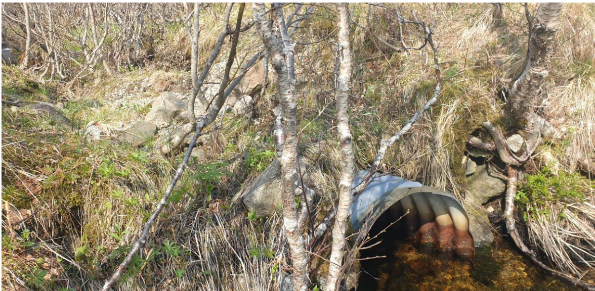
Figur 5-30: Stikkrenne og vei over Daleelva der den delvis er vasket ut, mai 2023.
