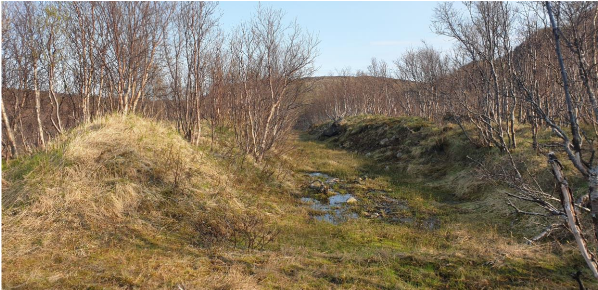
Figur 5-27: Terrenget ved målområdet viser tydelig en opparbeidet voll (til venstre i bildet). Noe av massene som tidligere har blitt gravd opp er også lagt oppå eksisterende terreng til høyre i bildet. Bildet er tatt fra nord mot sør, mai 2023.
