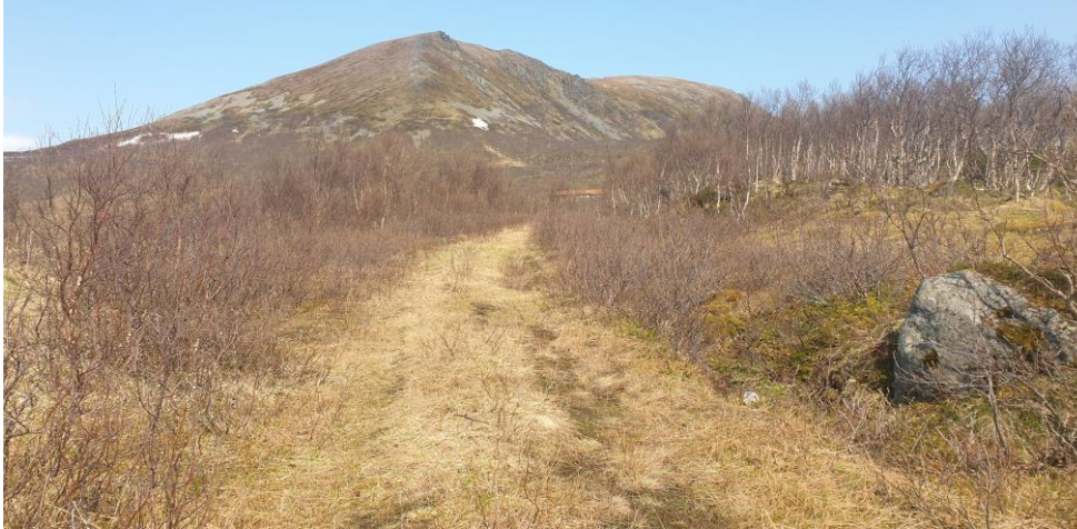
Figur 5-55: Veien på moreneryggen sett fra sørvest. Veien skal arronderes slik at veiformen etter hvert forsvinner. Vegetasjonsmasser tas til side og massene i grunnen rufses og tilpasses tilstøtende terreng. Vegetasjonsmassene legges tilbake slik at veien etter hvert gror igjen. Hvis det blir behov kan veien stedvis benyttes til deponi av overskuddsmasser, må avklares med byggherre.
