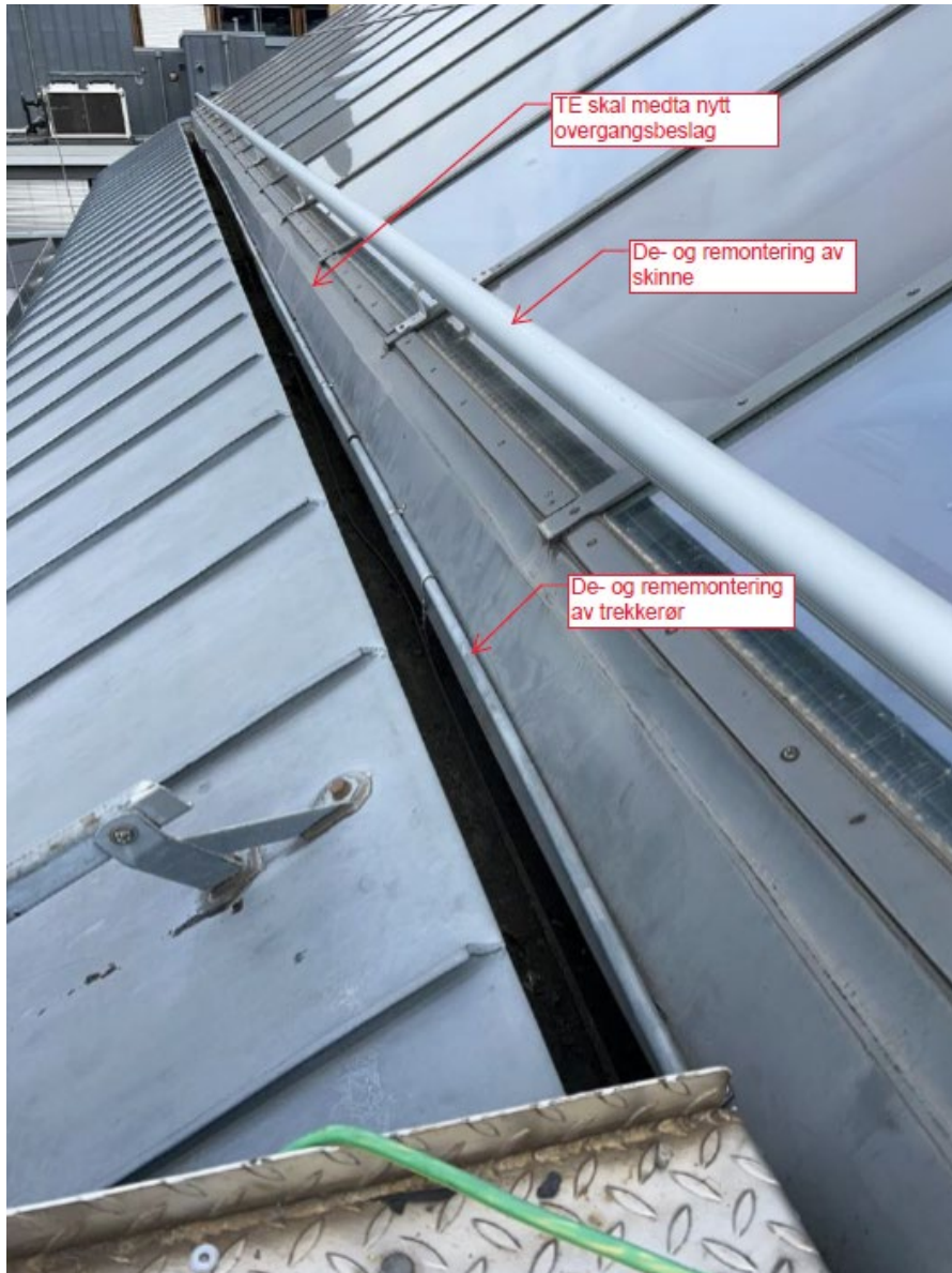
Figur 2.6-2. Bilde viser del av på beslag og skinne/rør som må de- og monteres.
